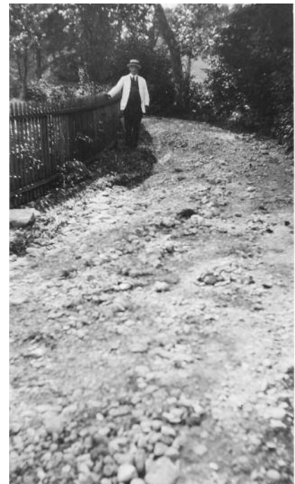
Heftiges Unwetter im Bereich der Herrenfahrstrasse im Jahr 1932.
