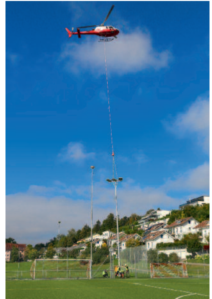
Kunstrasen: Helikoptereinsatz bei der Montage der neuen Beleuchtung.
