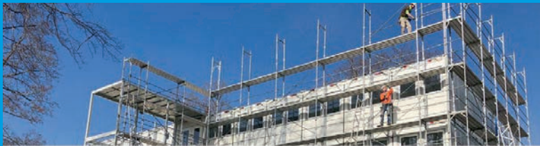
Wohncontainersiedlung am Standort Gottlieben: Das Gerüst wird demontiert.
