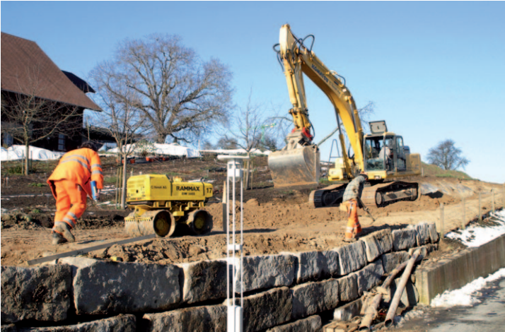
Baubeginn für die Verlängerung des Gemeindehausweges.
