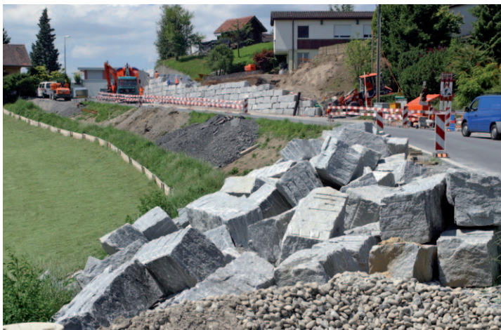
Erstellung von neuen Stützmauern an der Kreuzbuchstrasse.
