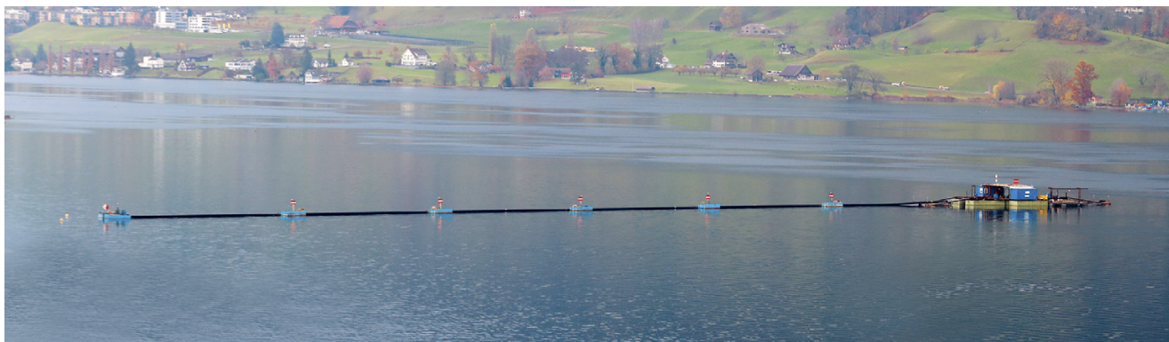
Zwischen Küssnacht und Merlischachen wurde ein 4 km langer Abschnitt der Transportwasserleitung auf den Seegrund gelegt. Das Bild zeigt die Vorbereitungsarbeiten in Merlischachen mit dem langen Führungsrohr für das Absenken der Transportwasserleitung.
