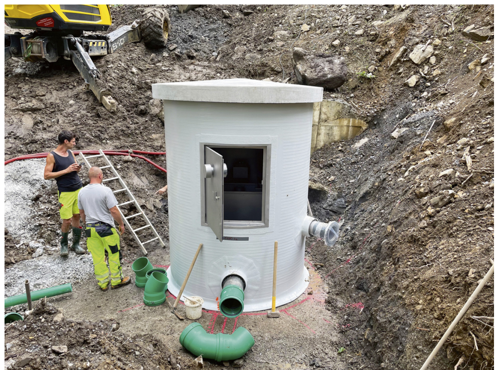
Quellsanierung im Gebiet Lauerz, Brunnenstube im Rohbau.
