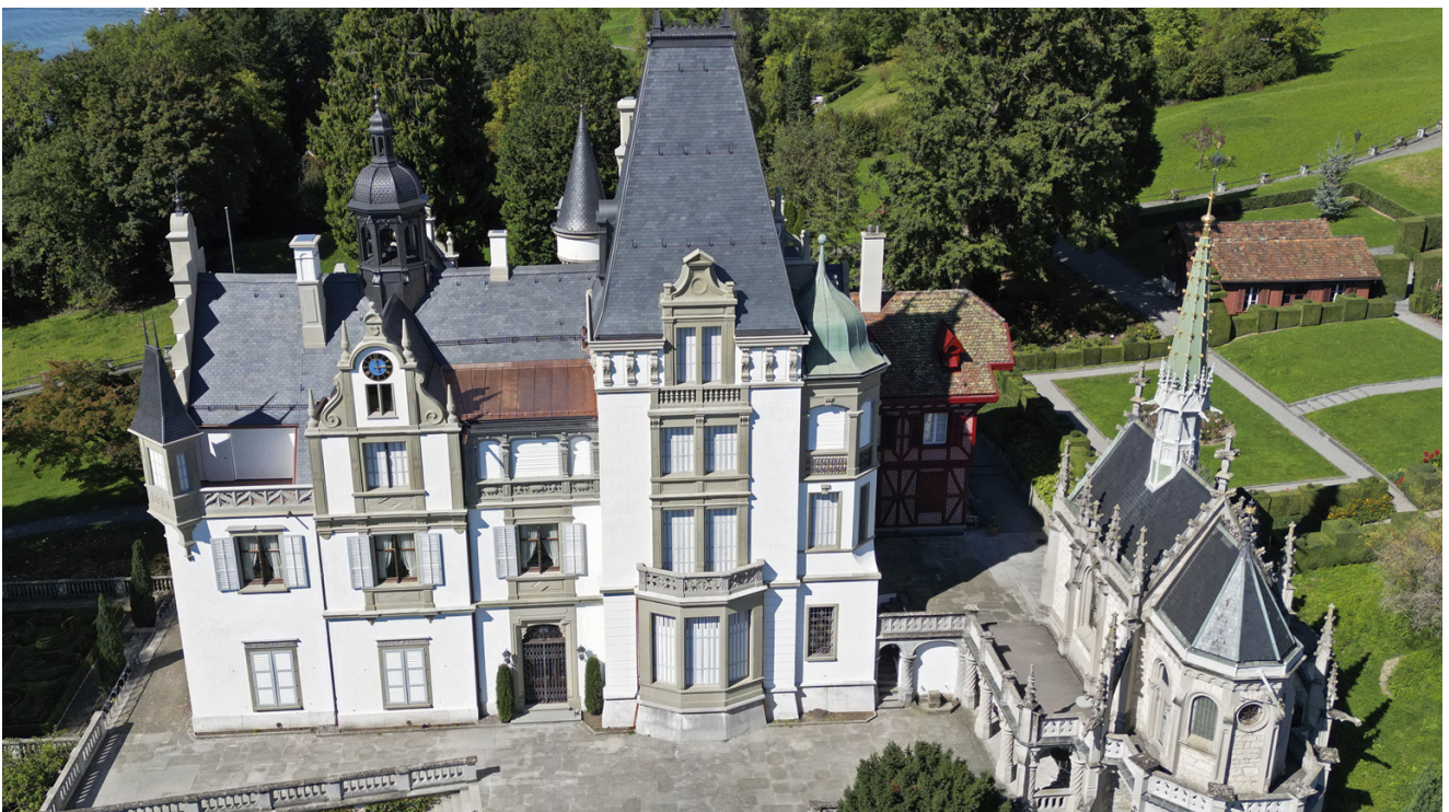
Die Dachsanierung des Schloss Meggenhorn ist abgeschlossen.
