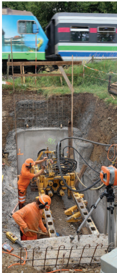
Die neue Leitungsquerung unterhalb der SBB-Bahnlinie wurde mit einer Horizontalbohrung erstellt.
