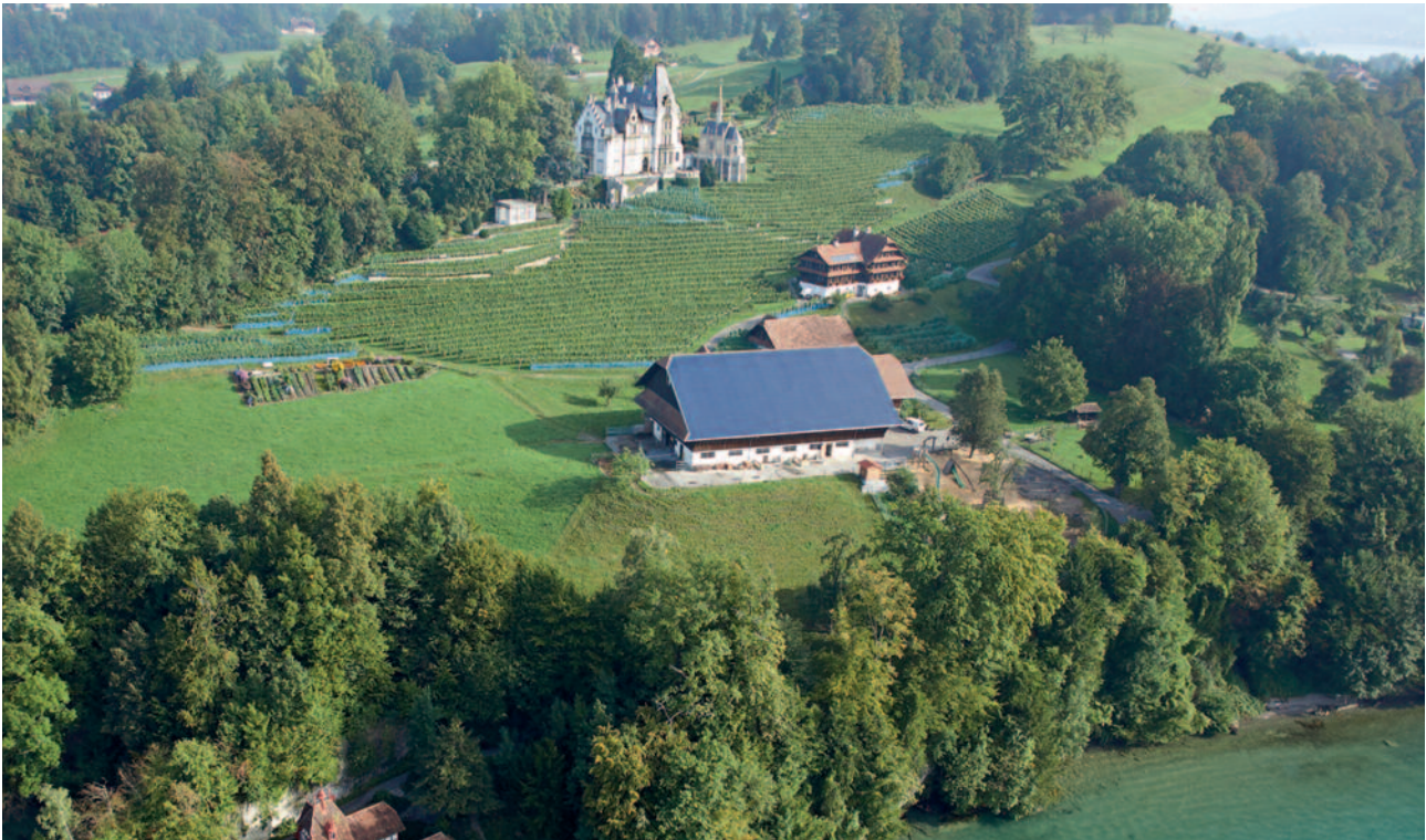
Die Anlage auf dem Dach der Scheune Meggenhorn (Bildmitte) hat bisher über eine halbe Mio kWh erneuerbare Energie produziert.
