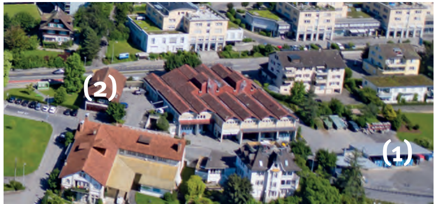
Der Werkhof der Gemeinde (Bildmitte) aus der Luft. Der Ökihof soll vom heutigen Standort (1) an die westliche Arealgrenze (2) verschoben werden.
