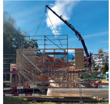
Arbeiten an der Aussenhülle des Pfadiheims.
