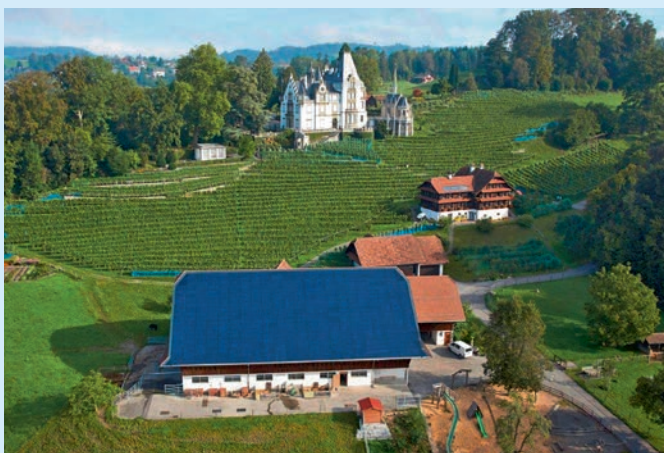
2013: Die PV-Anlage auf dem Dach der Meggenhornscheune erhält den Schweizer Solarpreis.
