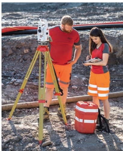
Mitarbeitende der Trigonet AG bei Vermessungsarbeiten.
