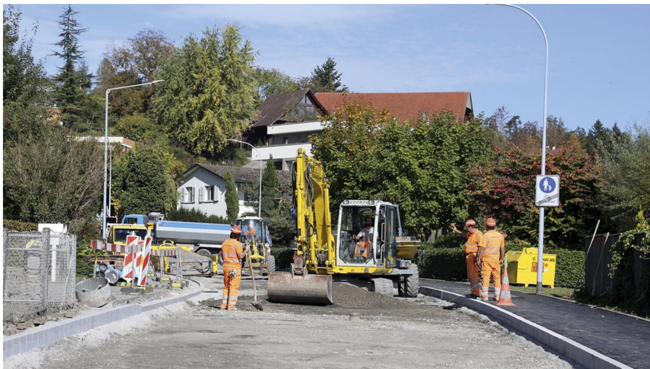
Bei der Adligenswilerstrasse (Abschnitt Obermatt-Tschädigen) wurden die Wasser- und Abwasserleitungen saniert.
