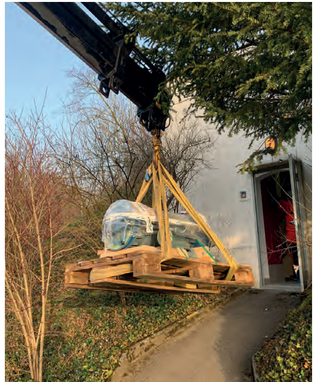
Transport der revidierten, rund 800 kg schweren Pumpe mit einem Lastwagen zum Reservoir.
