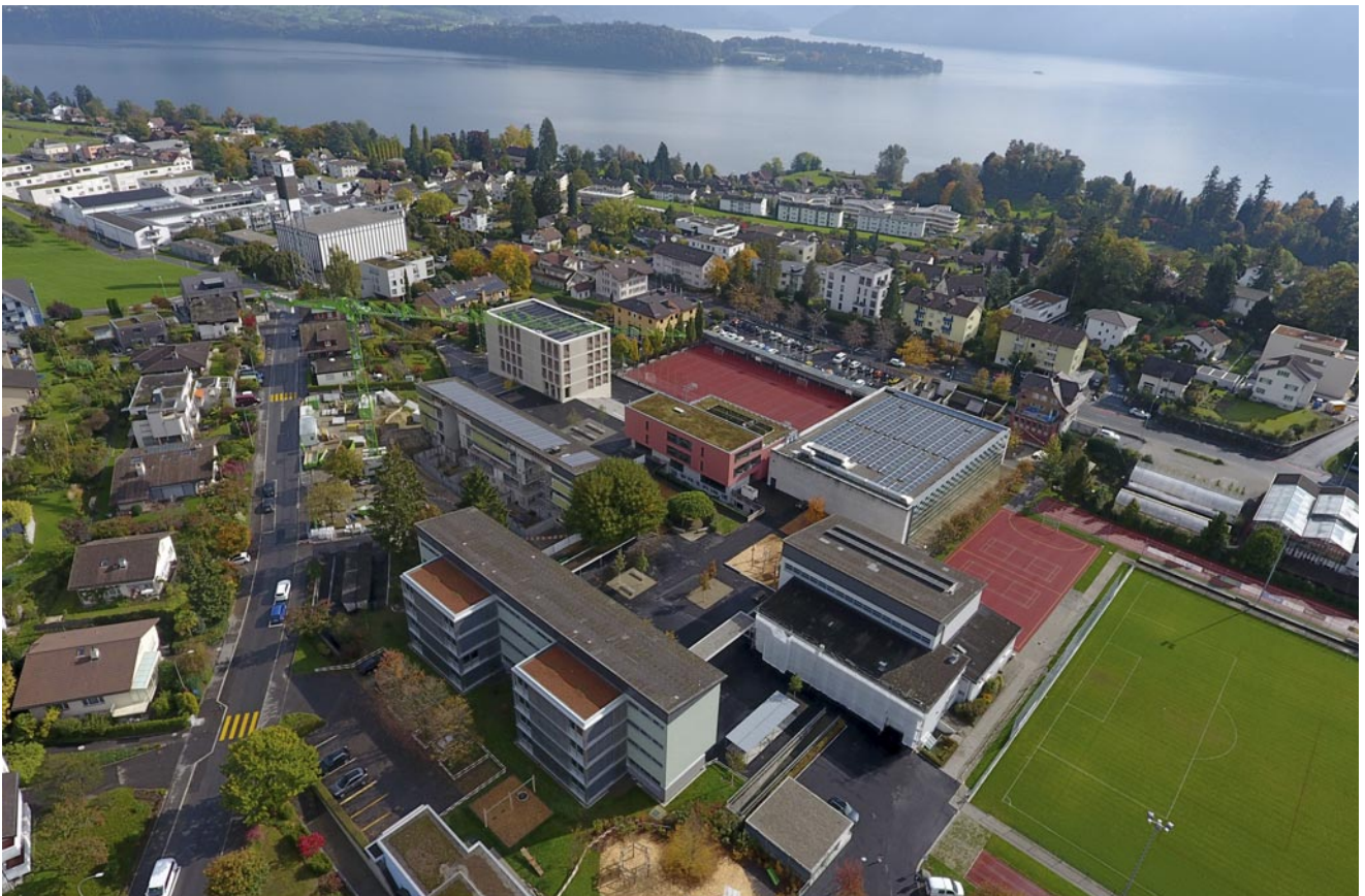
Flugbild des Schulzentrums Hofmatt. Nachdem das Schulhaus Hofmatt 2 saniert und erweitert wurde, folgt bis 2020 als letzte Etappe das Hofmatt 1.
