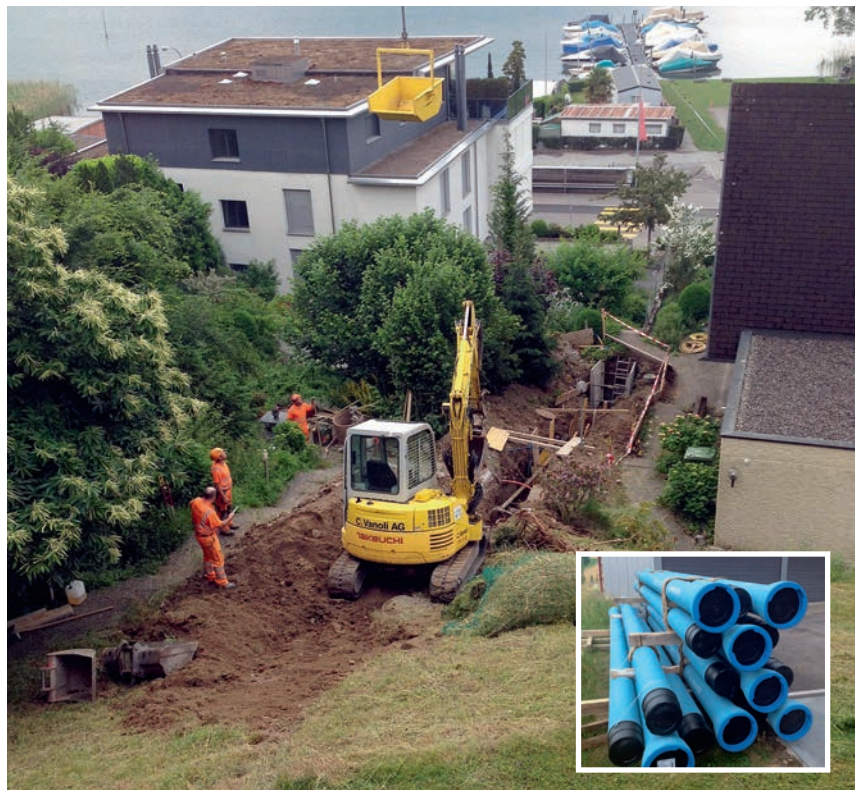
Bauarbeiten aufgrund eines Schadenfalls in Merlischachen.
