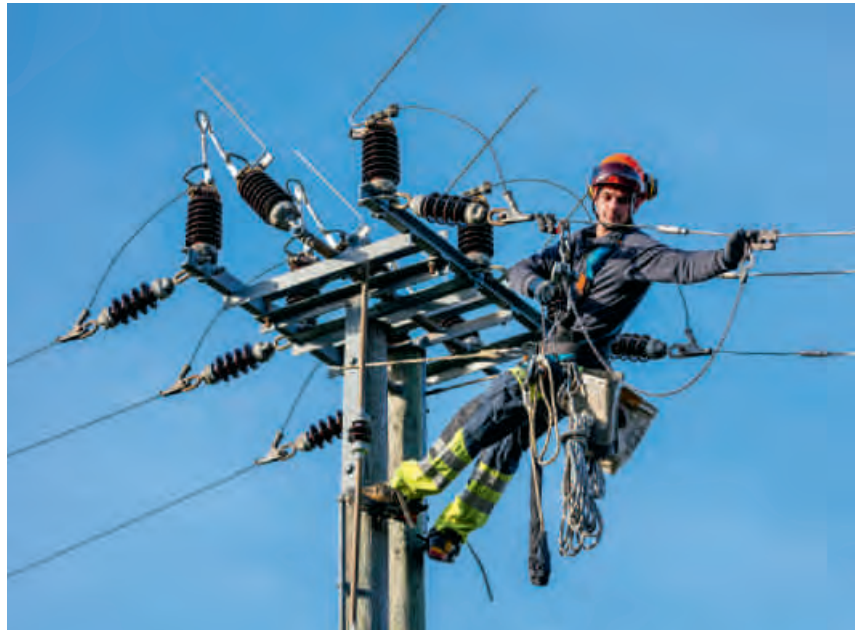
Arbeitsplatz in luftiger Höhe: Ein Netzelektriker der CKW bei seiner anspruchsvollen Tätigkeit im Dienste der Stromkunden.
