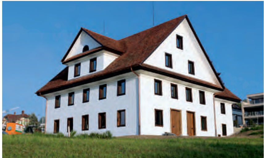
Aussenansicht der sanierten und umgebauten Kreuztrotte.
