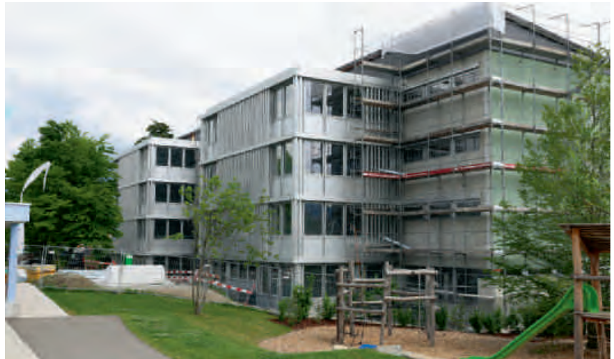
Auf der Nordseite des Schulhauses Hofmatt 2 wurden die sogenannten «Rucksäcke» mit den neuen Gruppenräumen angebaut.
