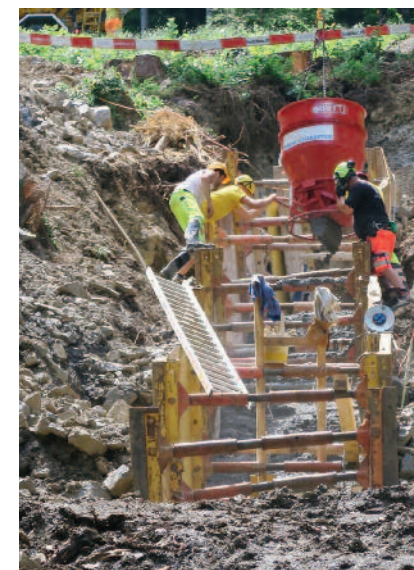
Links: Ausführung Fassungsabdeckung. Rechts: Lieferung Brunnenstube durch den Helikopter.
