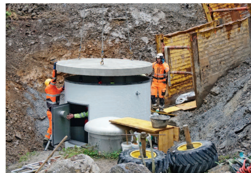
Versetzen der Brunnenstube.
