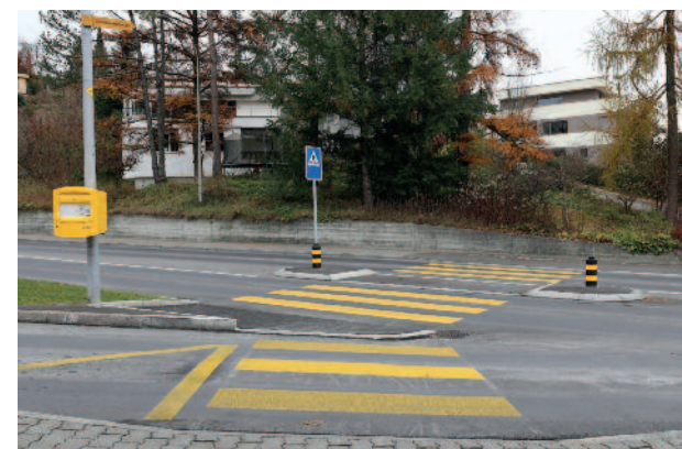
Neue Fussgängerinsel beim Fussgängerübergang bei der Bushaltestelle Tschädigen.
