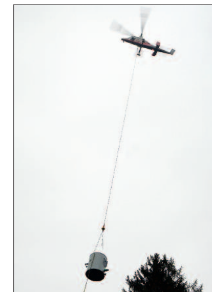
Links: Ausführung Fassungsabdeckung. Rechts: Lieferung Brunnenstube durch den Helikopter.
