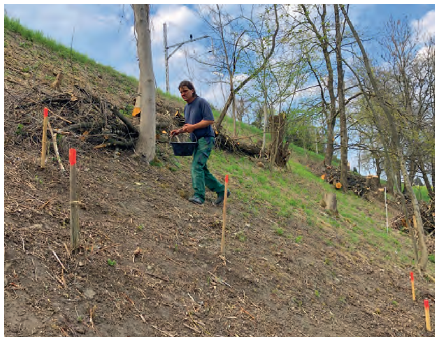
Vorbereitungsarbeiten auf der steilen Südseite des Bahndamms.
