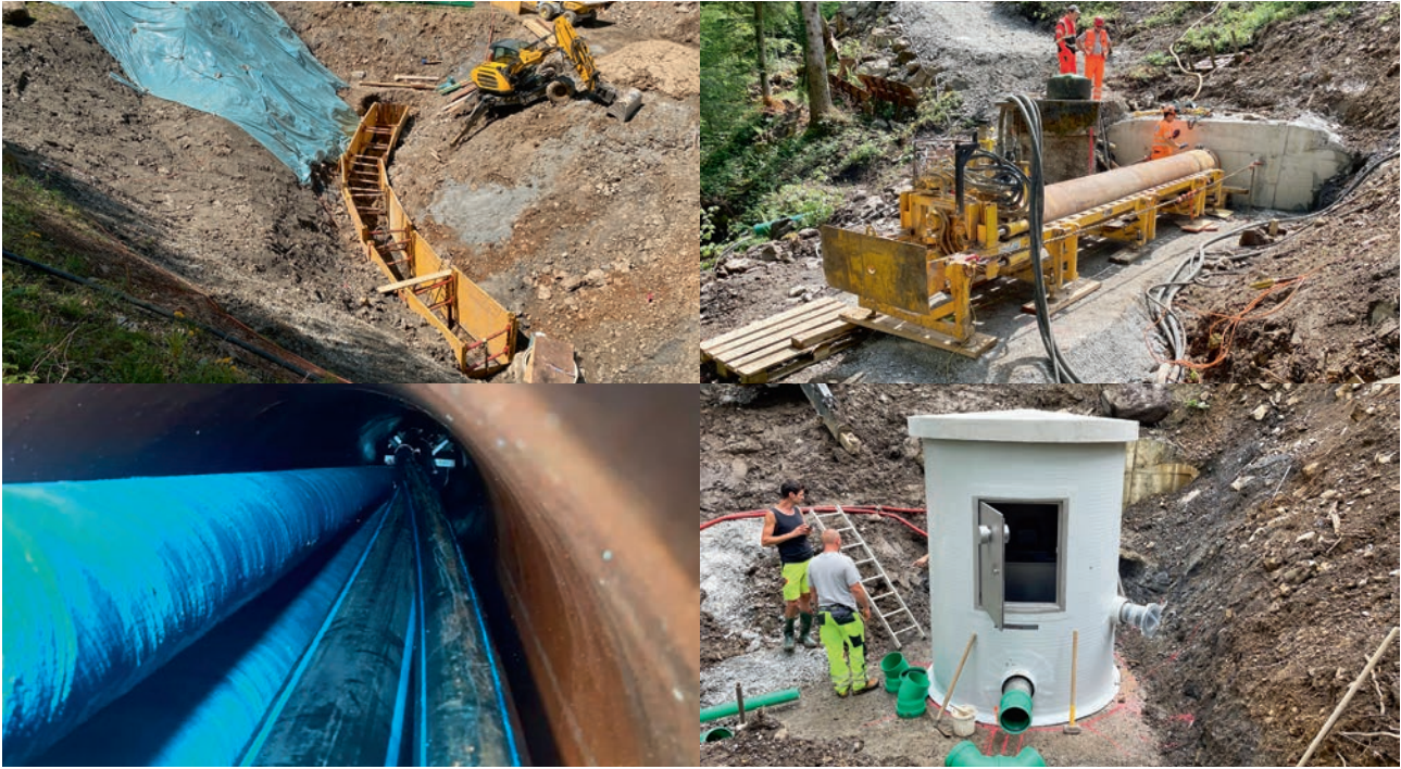
Oben links: Offener Graben Quellfassung 8. Oben rechts: Pressbohrgerät mit Stahlrohr. Unten links: Im Stahlrohr eingezogene Wasserleitungen. Unten rechts: Neue Brunnenstube.
