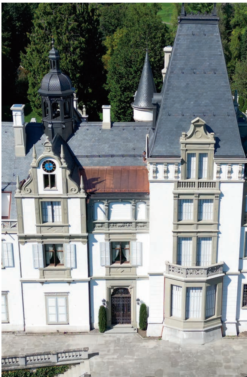
Dachsanierung abgeschlossen: Das Gerüst ist entfernt, das Schloss Meggenhorn erstrahlt in neuem Glanz.
