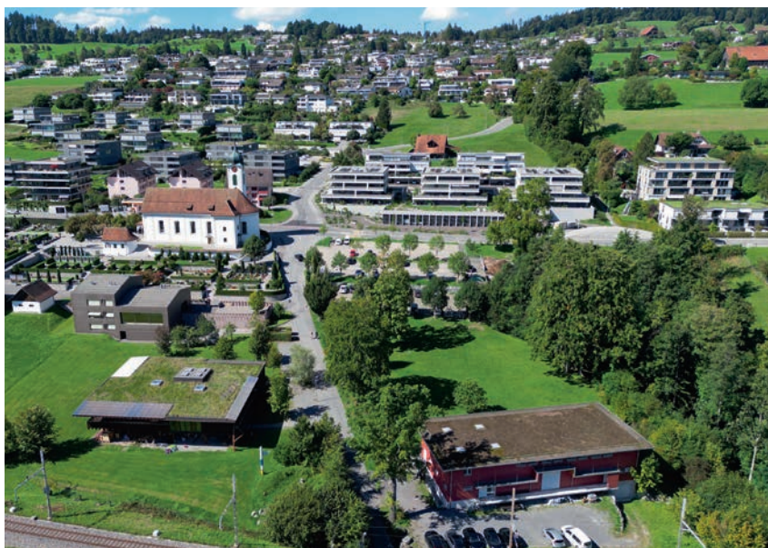
Der vorgesehene Standort für die Erstellung der temporären Wohncontainersiedlung für Schutzsuchende befindet sich im Gottlieben auf der Wiese oberhalb des Theatergebäudes.
