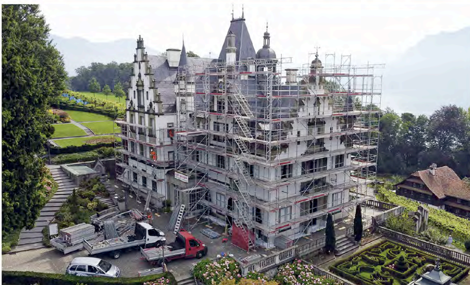
Von September 2021 bis Juni 2022 wird das Dach von Schloss Meggenhorn saniert.
