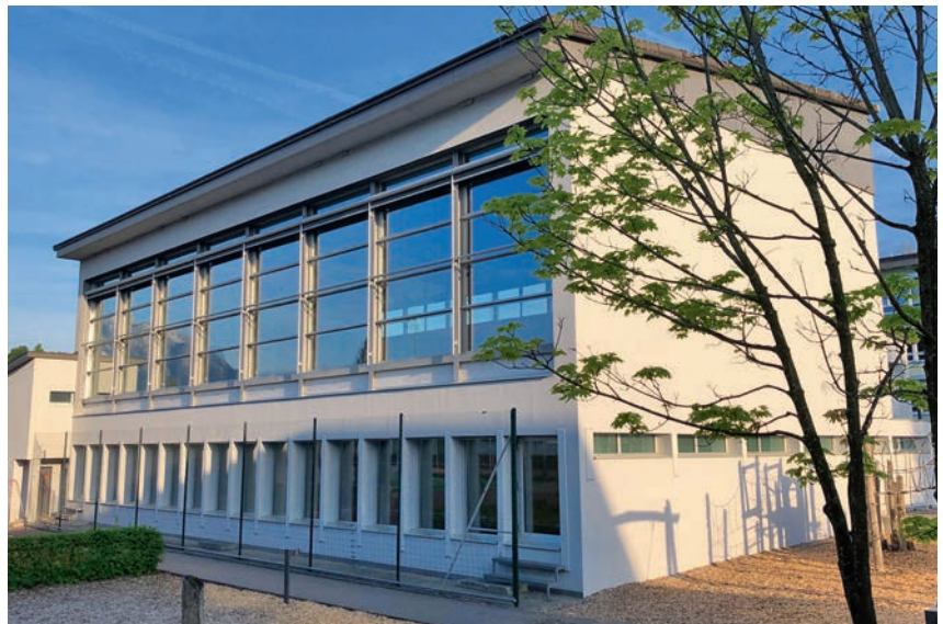
Das Hallenbadgebäude mit der darüberliegenden Turnhalle.
