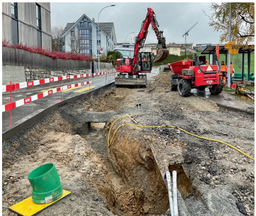
Baustelle Sanierung Schlösslistrasse am Dienstag, 28. November 2023.
