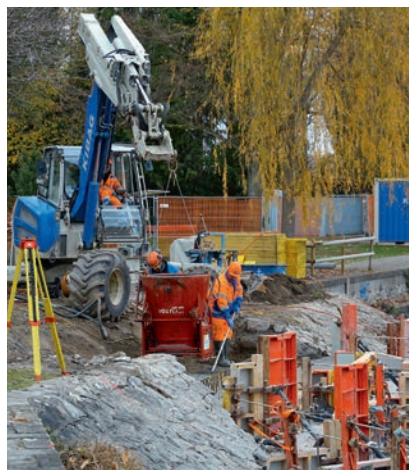
Sanierung Ufermauern: Betonieren.
