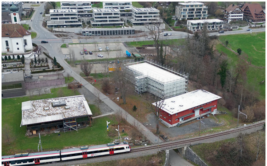
Erstellung der Wohncontainersiedlung im Gebiet Gottlieben.
