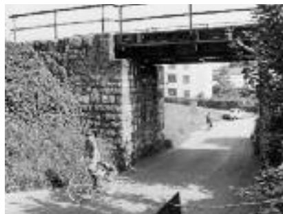
(5) Unterführung Habsburgstrasse vor der Vergrößerung
