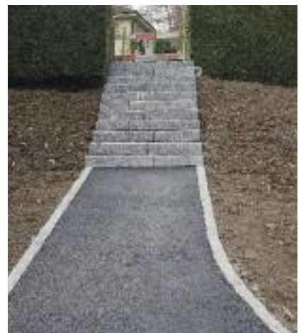
Der neue Fussgängerzugang zum Spielplatz St. Charles Hall.
