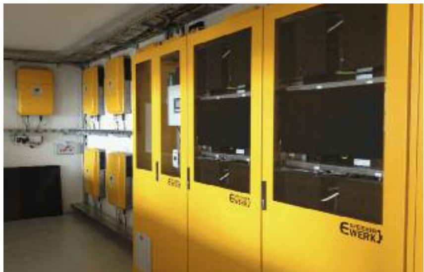
Scheune Meggenhorn: Solarkraftwerk mit Solarstromspeicher.
