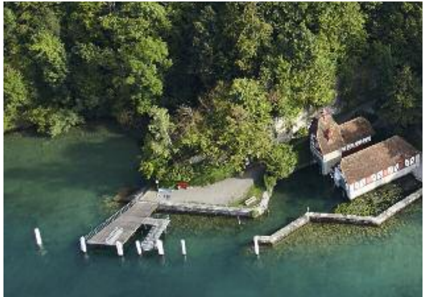
Das Archibild zeigt die SGV-Station Meggenhorn aus der Luft.
