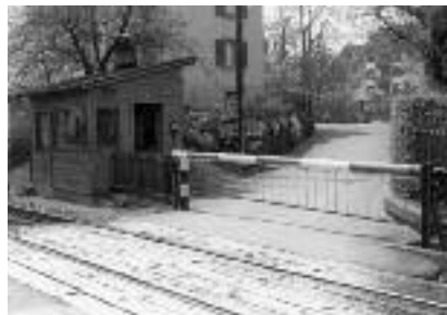
(3) Bahnübergang Mühleweiherweg mit Barrierenwärterhäuschen
