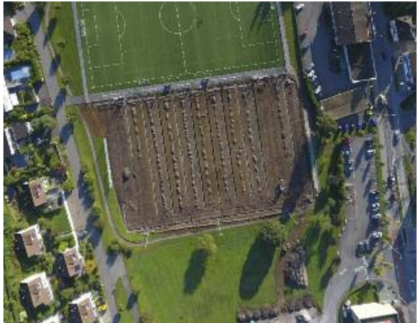
Sportanlage Hofmatt: Das Trainingsfeld West während der Sanierungsphase aus der Luft.
