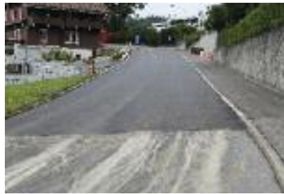
September 2016: Auf einem Abschnitt der Adligenswilerstrasse wurde ein lärmarmes Deckbelag eingebaut.
