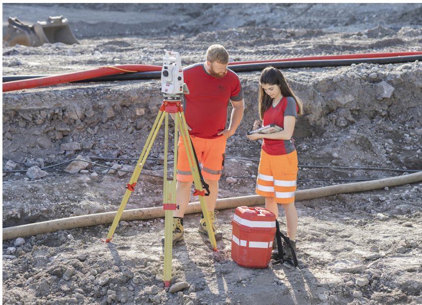
Eine Mitarbeiterin und ein Mitarbeiter der Firma Trigonet AG bei Vermessungsarbeiten.
