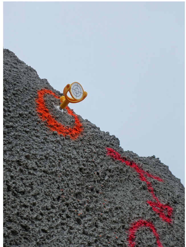
Geomonitoring Messpunkt Rutschgebiet Weggis, 2021.
