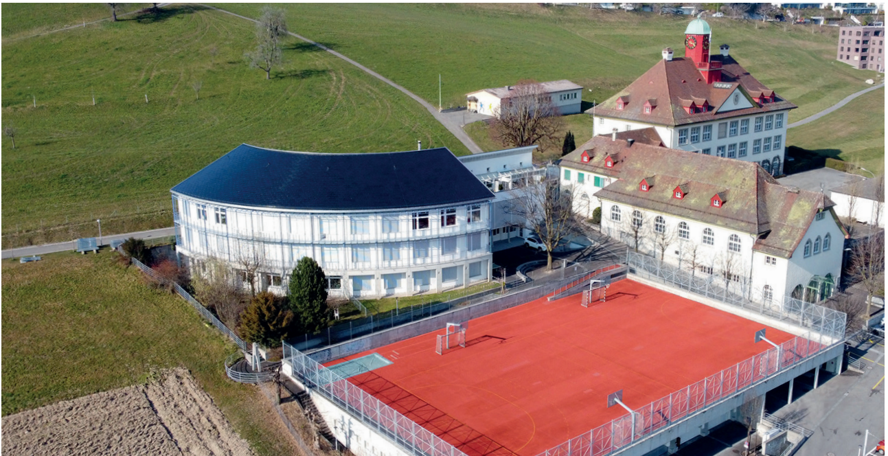
Ausgezeichnet: Die Photovoltaikanlage auf dem Dach des Schulhauses Zentral 2.
