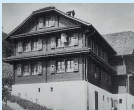
1982: Totalsanierung Bauernhaus. Foto aus der Broschüre «Schloss Meggenhorn» (1986)
