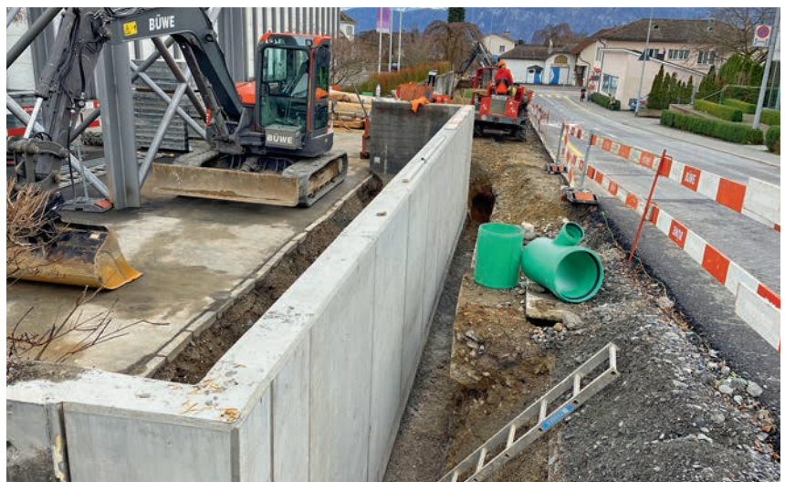
Sanierung Schlösslistrasse: Arbeiten im Bereich der Piuskirche.
