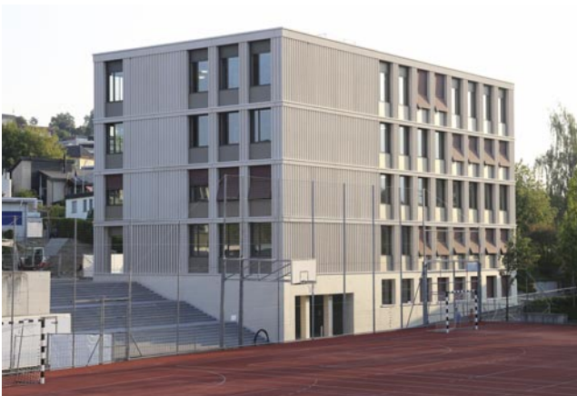
Neubau Schulhaus Hofmatt 4, welcher im September 2018 offiziell eröffnet wurde.
