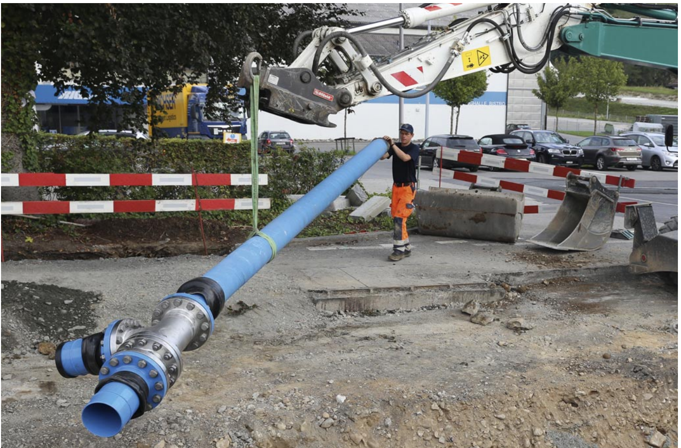
Ersatz eines Abschnitts der Transportwasserleitung Lauerz-Meggen: Bauarbeiten in Küssnacht.
