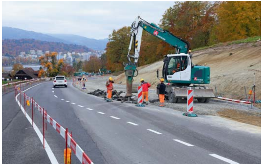
Baustelle des Kantons auf der Kantonsstrasse Richtung Luzern.
