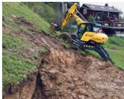
Grabarbeiten im steilen Gelände mit Schreitbagger.
