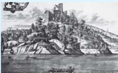
Die Ruine Neuhabsburg vom See vor Erstellung des Schlosses.
