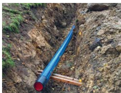
Wasserleitung PE ø 160 mm.
