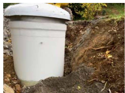
Be- und Entlüftungsschacht.
