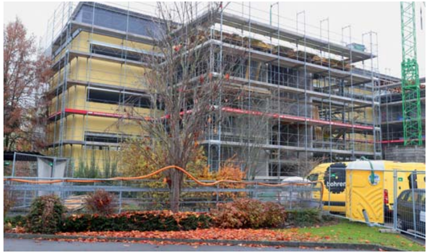
Blick von der Dreilindenstrasse zur Baustelle Schulhaus Hofmatt 2.
