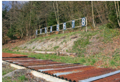
Scheibenstand der Schiessanlage Blossegg.
