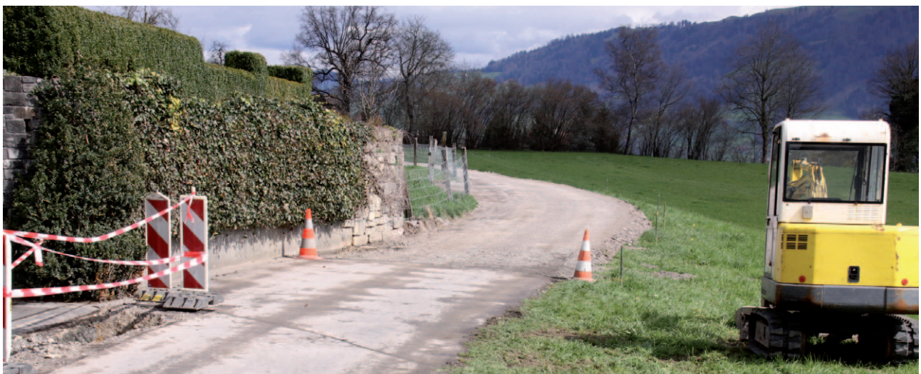
Im Bereich der Eichwaldstrasse wurde ein neuer Deckbelag eingebaut.
