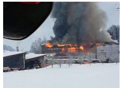
Zwei Produktionshallen der Sägerei Schilliger standen im Vollbrand, als die Megger Feuerwehrleute in Küssnacht eintrafen.
