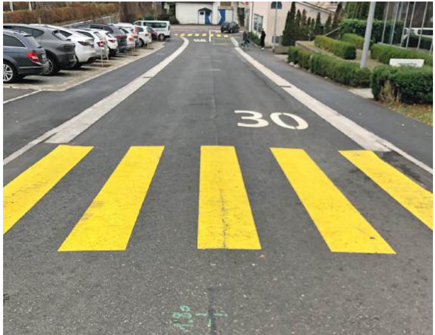
Die Arbeiten auf der Schlösslistrasse wurden mit dem Anbringen der Signalisation abgeschlossen. Im Sommer 2025 folgt noch der Einbau des Deckbelags.
