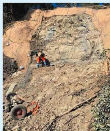
Sicherungsarbeiten bei der Badebucht
