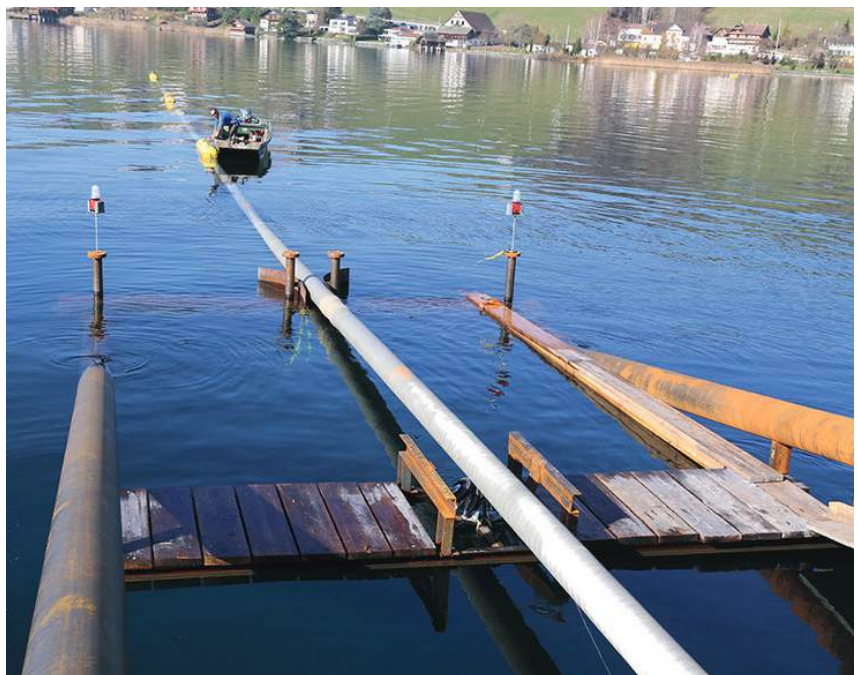
Erneuerung der Transportwasserleitung Lauerz-Meggen, Etappe B: Herzstück ist die neue Leitung zwischen Arth nach Immensee, welche wie beim Abschnitt von Küssnacht nach Merlischachen (Bild oben) in den See verlegt wird.
