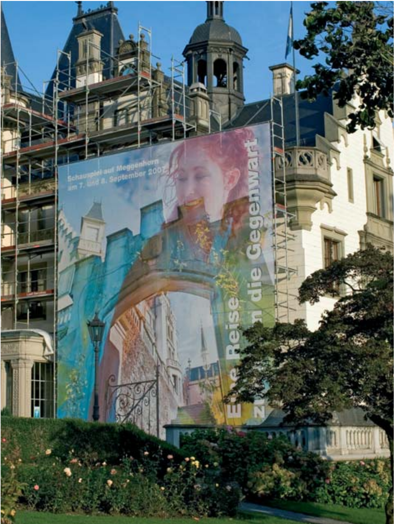
Gut investiertes Geld: Beim Schloss Meggenhorn konnte die 2. Etappe der Fassadenrestaurierung erfolgreich abgeschlossen werden.
