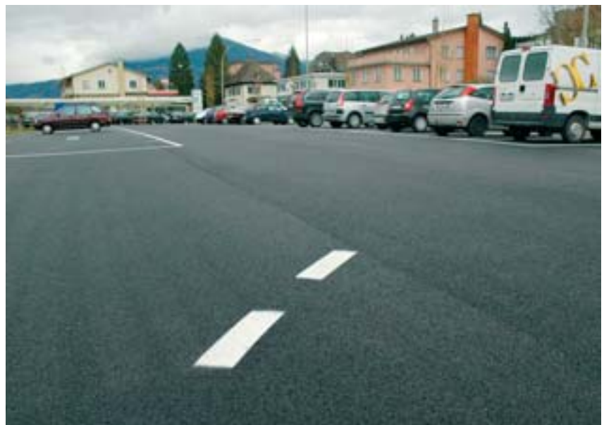
Mit der Erstellung der Parkplätze Mühlemoos (Bild) und Neuhöfli wurde das Parkplatzangebot in der Gemeinde erweitert.
