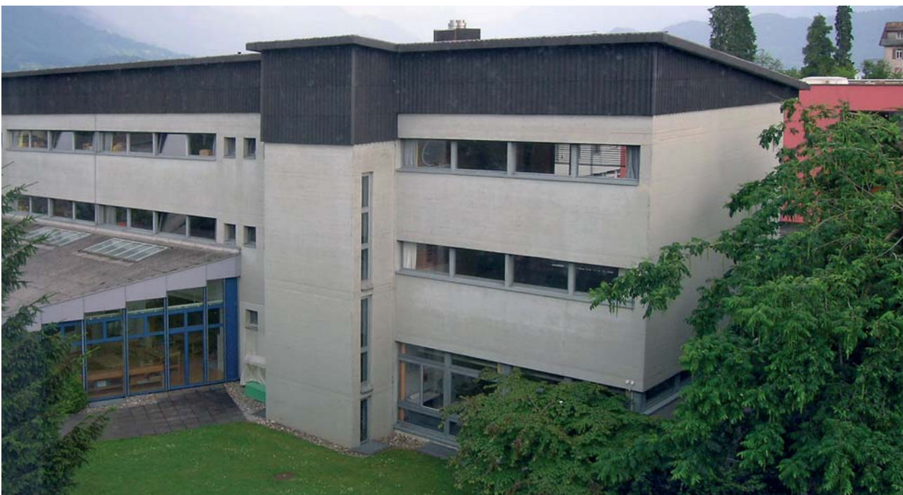
Bei der Schulanlage Hofmatt, welche 1964 und 1973 erstellt wurde, müssen unter anderem die Fassaden erneuert und wärmetechnisch optimiert werden.
