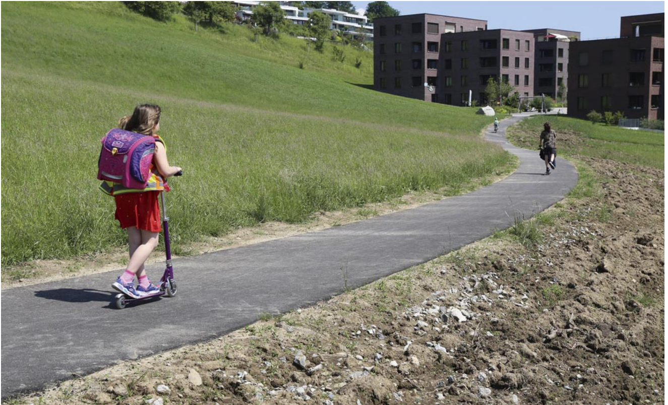
Die neue Fusswegverbindung zwischen dem Schulhaus Zentral und der Überbauung Bodenweid.
