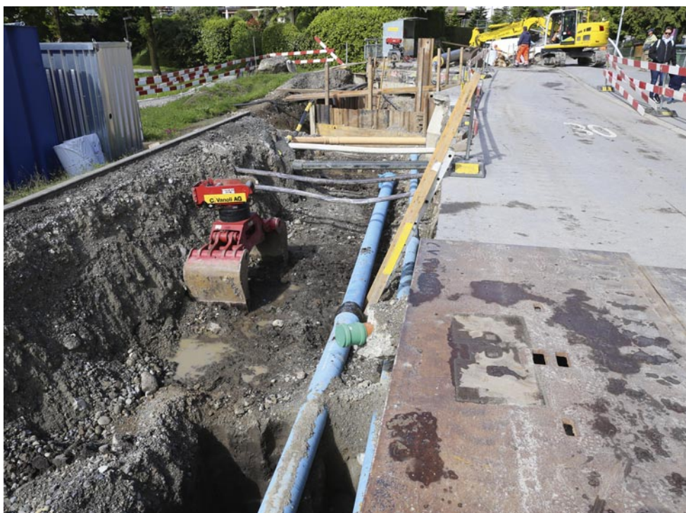
Die Unterquerung des Giessenbaches in Küssnacht stellte aufgrund der bestehenden Fundationspfähle eine besondere Herausforderung dar.
