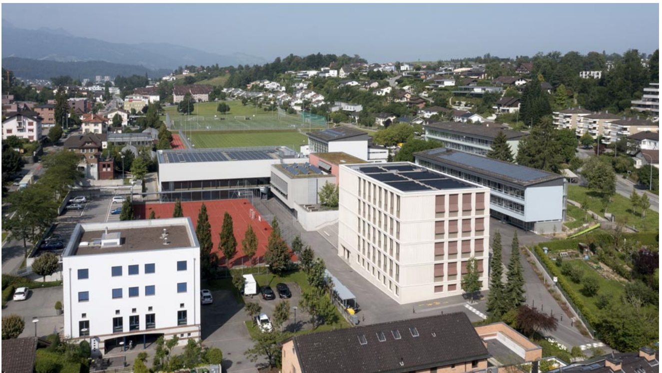
Die Sanierung und Erweiterung des Schulzentrums Hofmatt wurde 2021 abgeschlossen.
