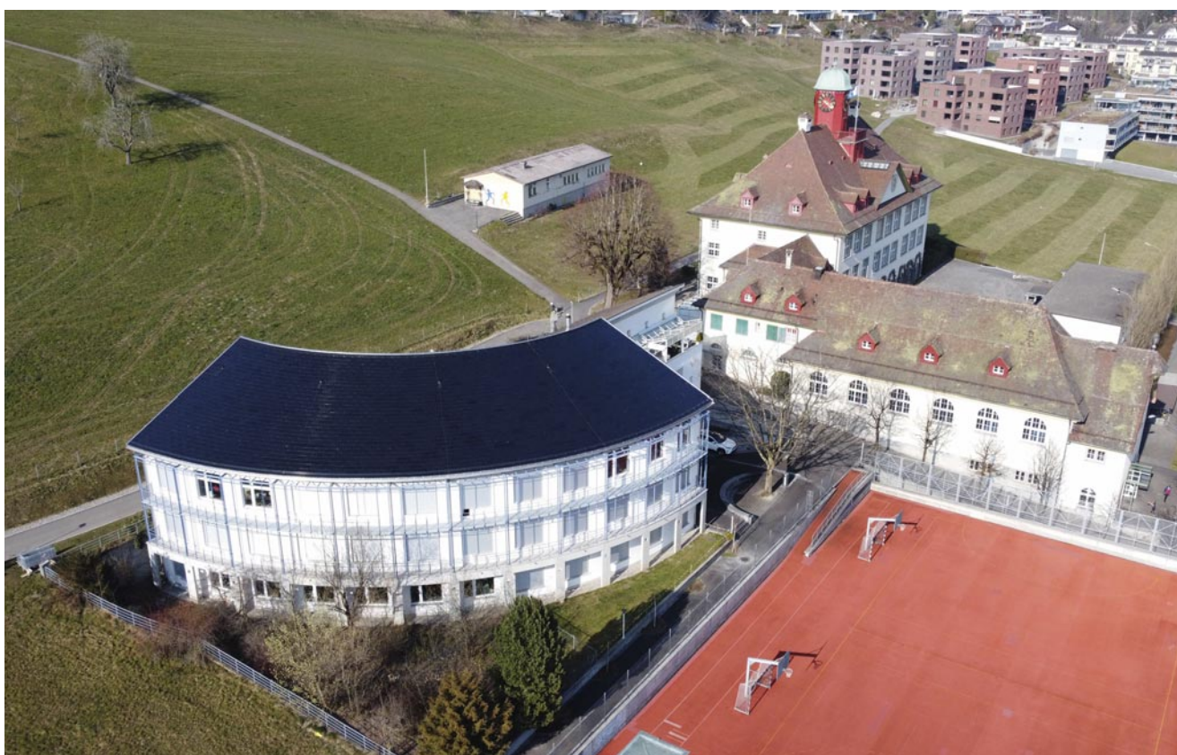
Luftaufnahme des sanierten Schulhauses Zentral 2 mit PV-Anlage auf dem halbrunden Dach.
