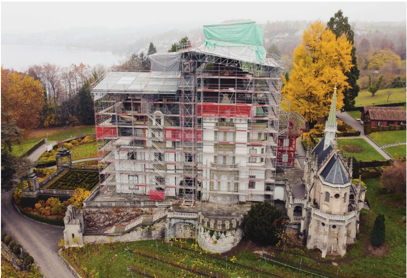
20. November 2021: Das Dach von Schloss Meggenhorn ist eingepackt.
