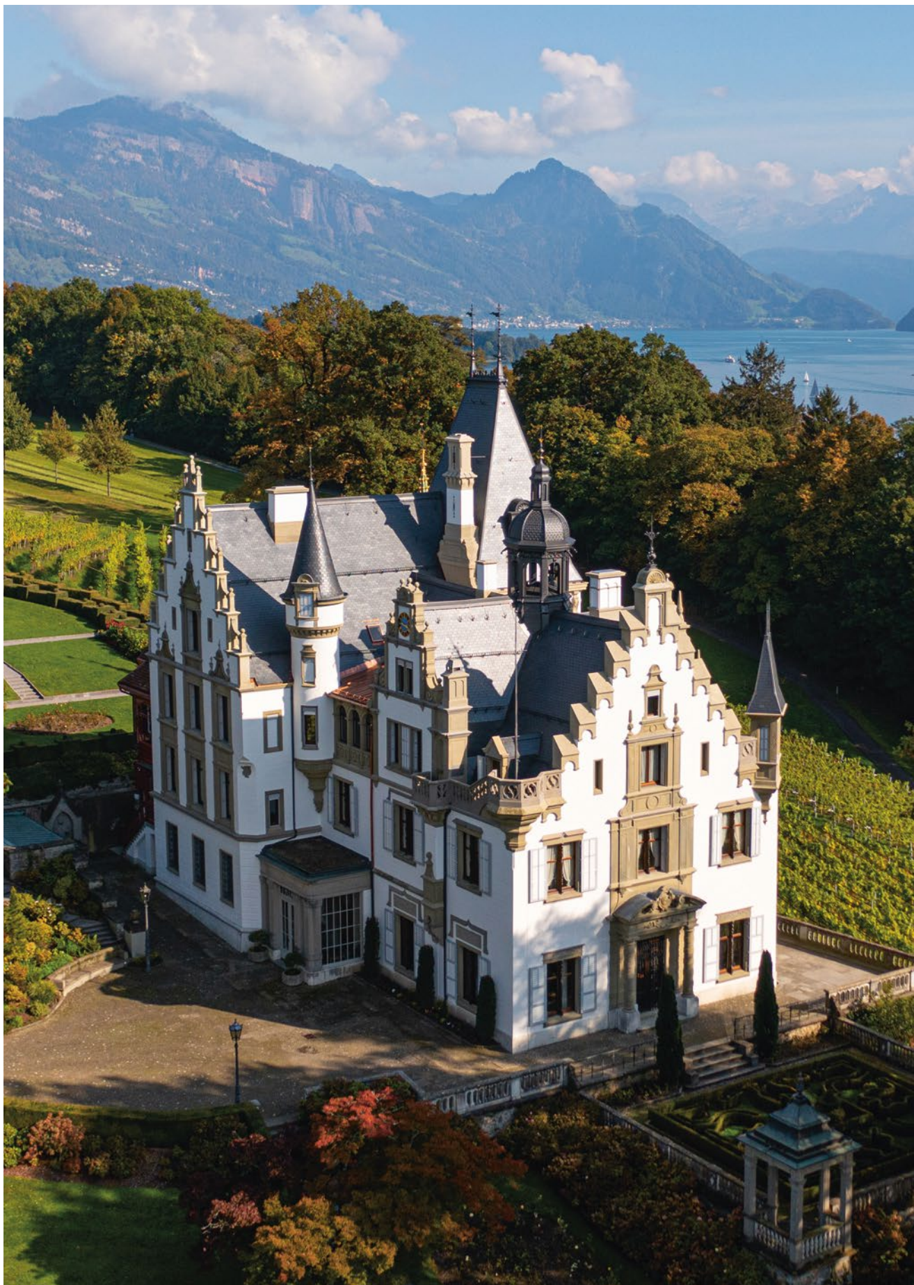
Das Dach von Schloss Meggenhorn strahlt nach der Sanierung im neuen Glanz.
