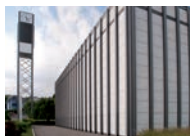
2 Piuskirche Die aus architektonischen Gründen über die Kantonsgrenze hinaus bekannte Piuskirche ist Pius X geweiht. Sie wurde in den Jahren 1964 bis 1966 nach Plänen des Schweizer Architekten Franz Fleg erbaut. Ihre wahre Schönheit zeigt sich besonders von innen. Die freestehende Piuskirche besteht aus griechischem Marmor. Die 888 Platten wurden in Carrara (Italien) geschritten und geschliffen.
