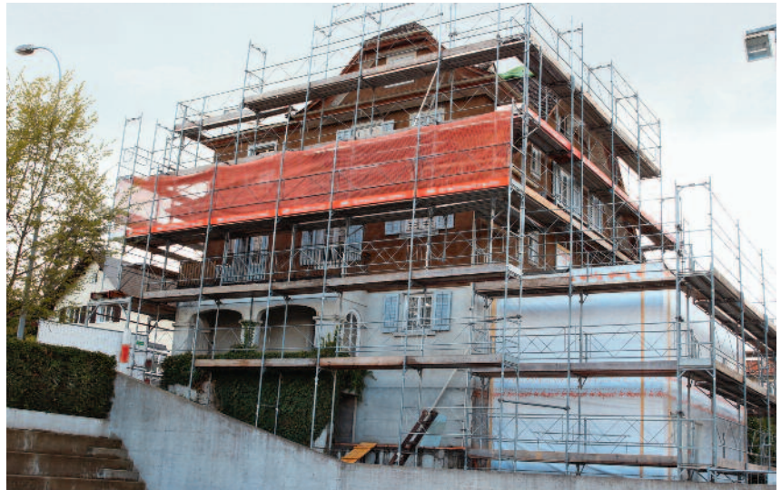
Der Anbau auf der Nordseite des Hauses Luzernerstrasse 14 ist erstellt (rechts).
