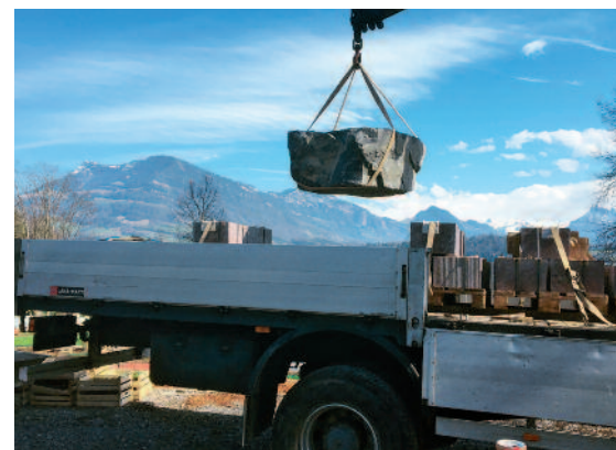
Impressionen von den Bauarbeiten.
