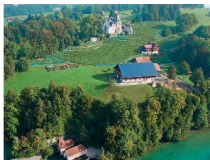
Die Gemeinde geht mit dem guten Beispiel voran. Sie betreibt auf dem Dach der Scheune Meggenhorn ein Solarkraftwerk.
