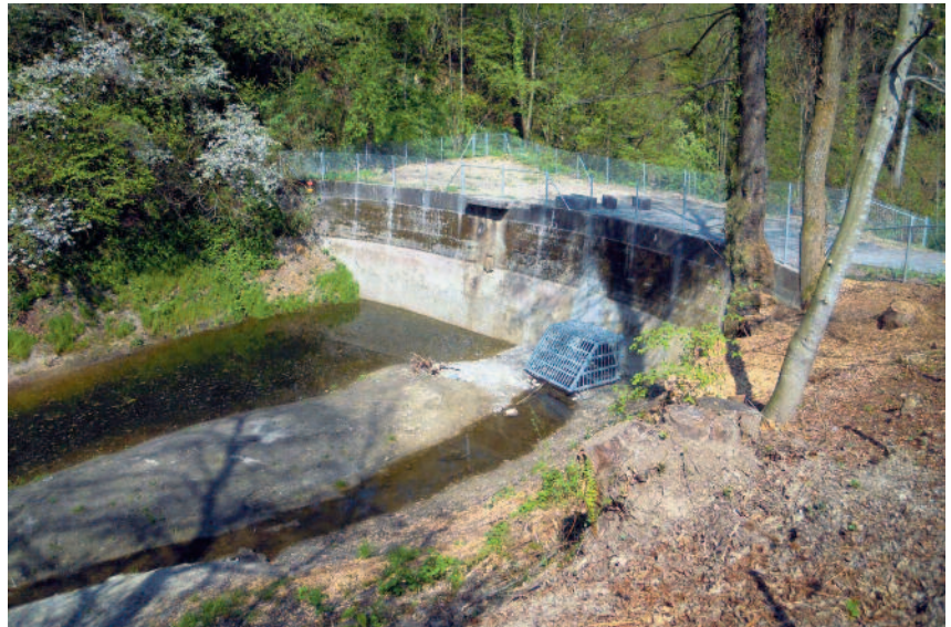
Stauanlage Ebnetweiher: Die Dammkonstruktion bleibt weiterhin erhalten
