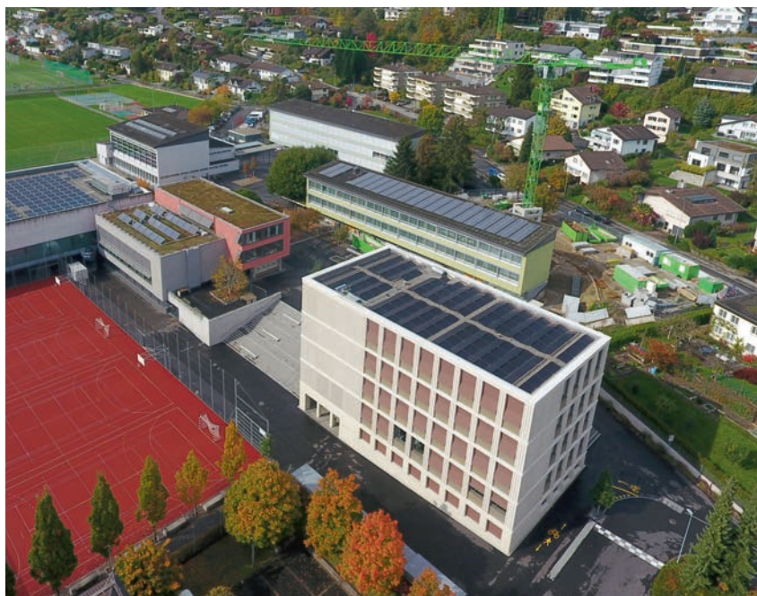
Flugbild des Schulzentrums Hofmatt. Nachdem in diesem Jahr das Schulhaus Hofmatt 2 saniert und erweitert wurde, folgt bis Sommer 2020 als letzte Etappe das Schulhaus Hofmatt 1 (gelb in der Bildmitte).
