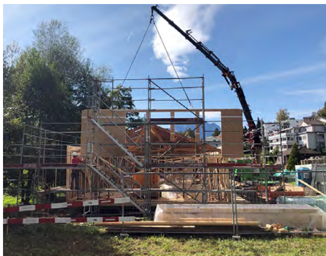
Die Aussenhülle nimmt Form an!
