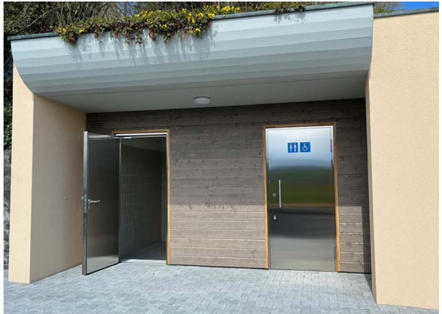
So präsentiert sich die WC-Anlage nach der Sanierung.
