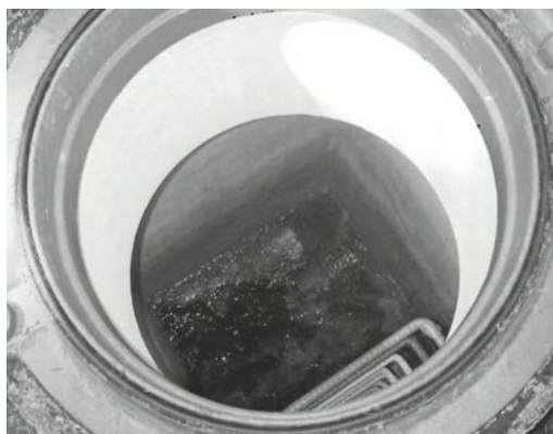
Einblick in eine der Quellfassungen im Rigigebiet, in denen das Megger Wasser gesammelt wird.
