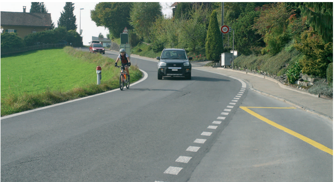
Für die Sanierung der Kreuzbuchstrasse beantragt der Gemeinderat einen Kredit von 6,1 Mio. Franken.
