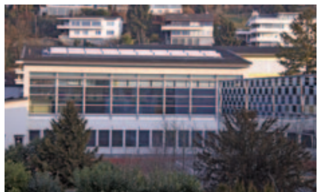
Sanierungen Schulanlage Hofmatt: Auf dem Dach des Hallenbadgebäudes wurde eine thermische Solaranlage montiert.
