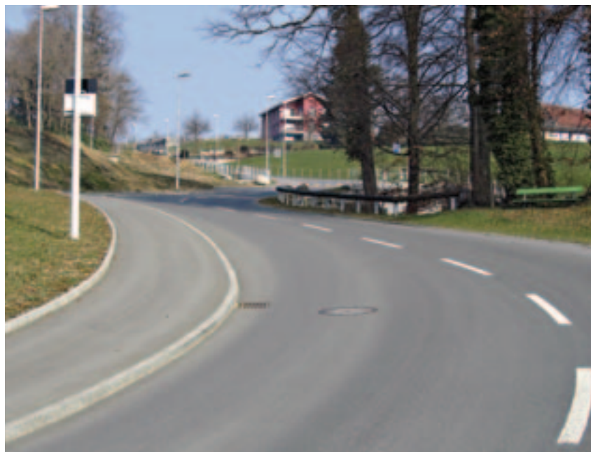
Sanierung der Sentibühlstrasse: Mit dem Projekt «Trottoir Sentibühlstrasse Süd» wurde die letzte Etappe abgeschlossen.
