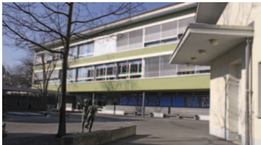
Schulanlage Hofmatt energietechnisch auf den neuesten Stand gebracht: Während gut vier Jahren wurden die Hüllen der verschiedenen Gebäude umfassend saniert.
