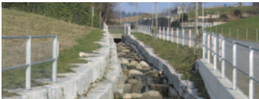
Der bisher stark kanalisierte Dörflibach wurde mit geeigneten Mitteln teilweise renaturiert.
