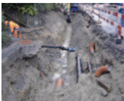
Werkleitungsarbeiten Kanalisation, Wasser- und Gasleitung
