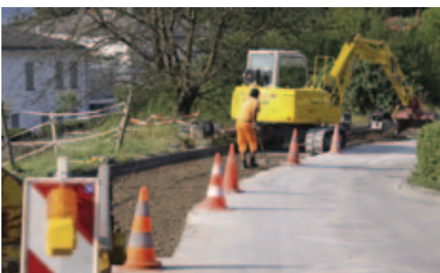
Investitionen im Bauwesen: Neuer Strassenoberbau und Ersatz der 60 Jahre alten Wasserleitung an der Altstadtstrasse.
