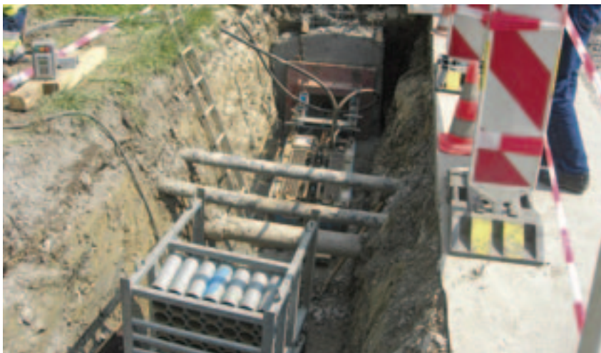
Das umfangreiche Kanalisationsnetz der Gemeinde erfordert umfangreiche Unterhalts- und Erneuerungsarbeiten
