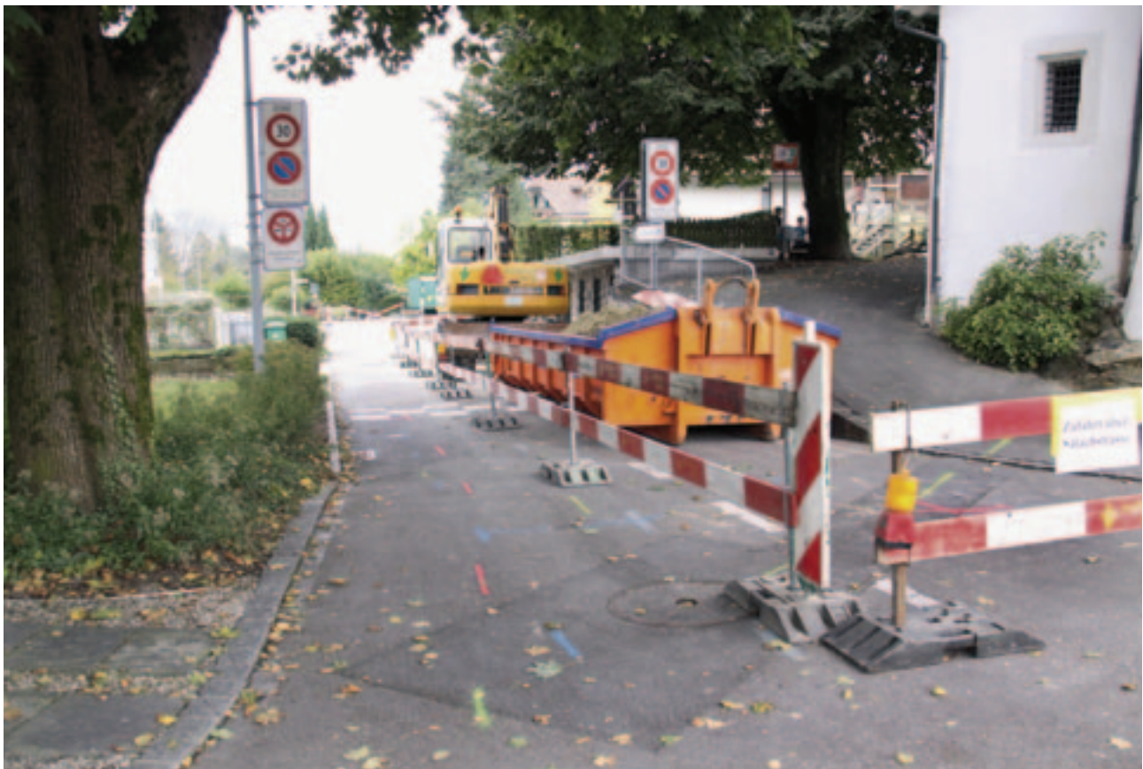
Tiefbauarbeiten 2011 bei der Benzeholzstrasse: Ein grosser Teil der für das Jahr 2012 budgetierten Investitionen entfällt auf Projekte des Hoch- und Tiefbaus.
