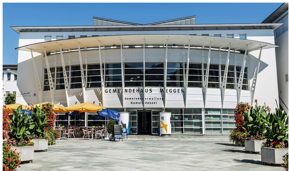
Beim Gemeindehaus wird der Fensterersatz geplant.
