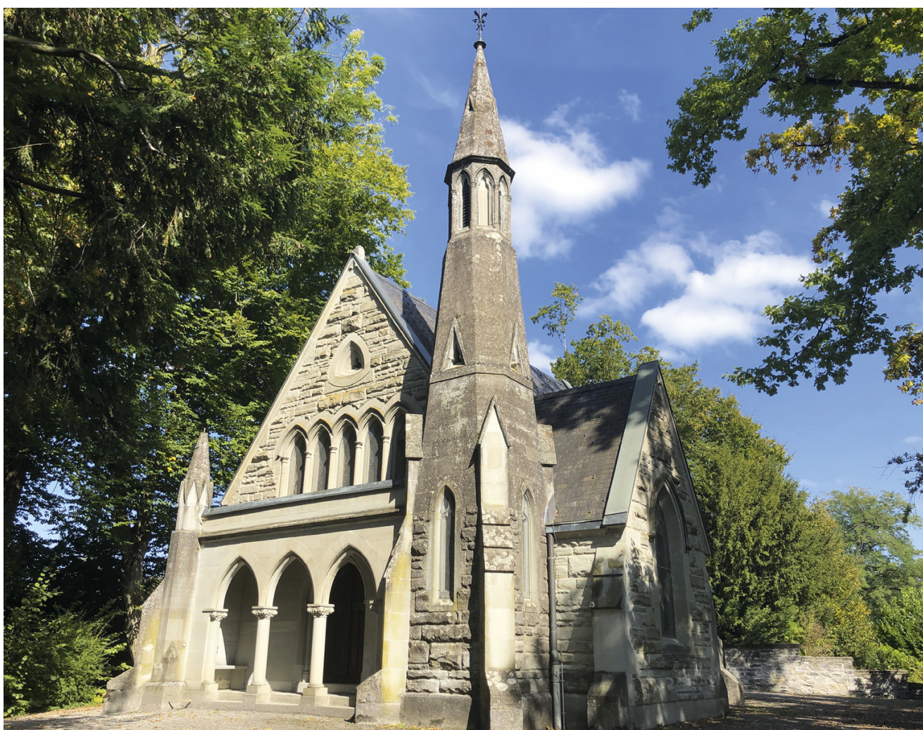
Bei der Kapelle im Englischen Friedhof stehen Sanierungsarbeiten an.
