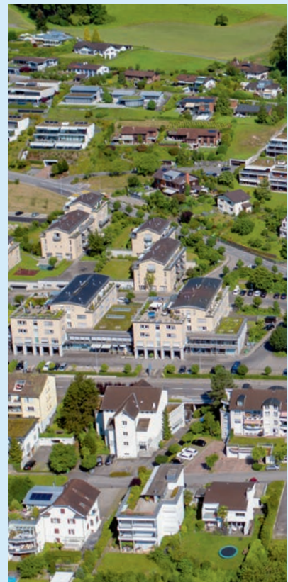
Meggen aus der Luft: Haben Sie Fragen zur Gesamtrevision der Ortsplanung Meggen? Dann laden wir Sie zu den Fragestunden im Gemeindehaus ein.
