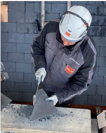
Ein Dachdecker beim Zuschneiden eines Schieferziegels.
