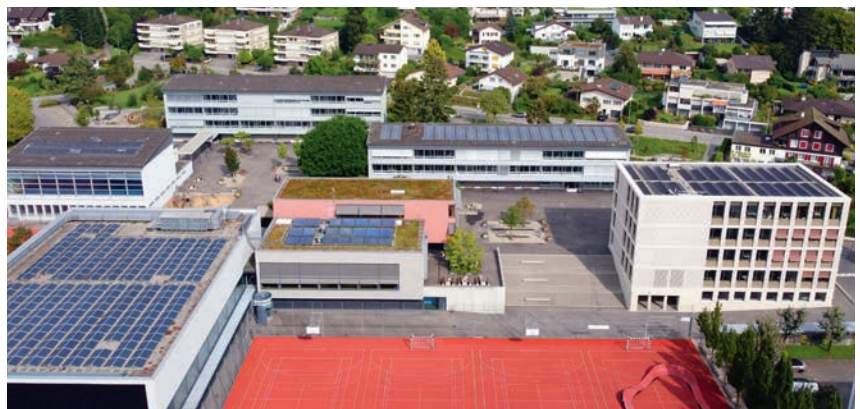
Die Gemeinde geht mit gutem Beispiel voran und betreibt heute fünf grosse PV-Anlagen, weitere sind in Planung. Bild oben: PV-Anlage auf dem Dach des Zentral 2. Bild unten: PV-Anlagen auf den Gebäuden des Schulzentrums Hofmatt.
