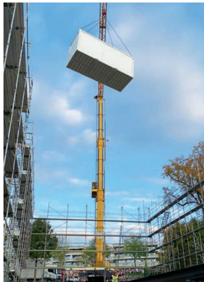
Montage eines Containerelements auf der Baustelle am Standort Gottlieben.
