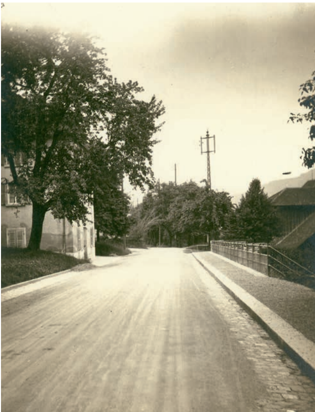
1923: Sanierung der Kantonsstrasse Links: Frohmüt. Rechts: Letten
