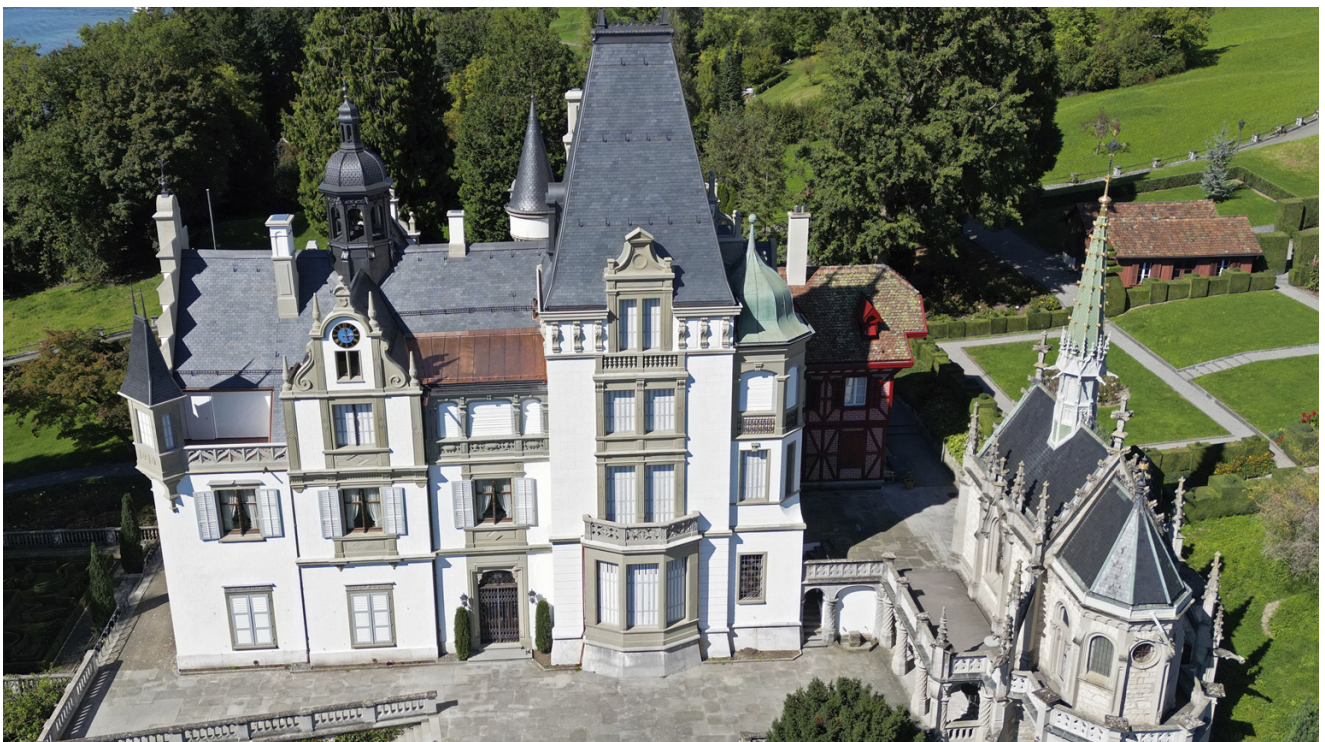
Die Dachsanierung des Schloss Meggenhorn ist abgeschlossen.
