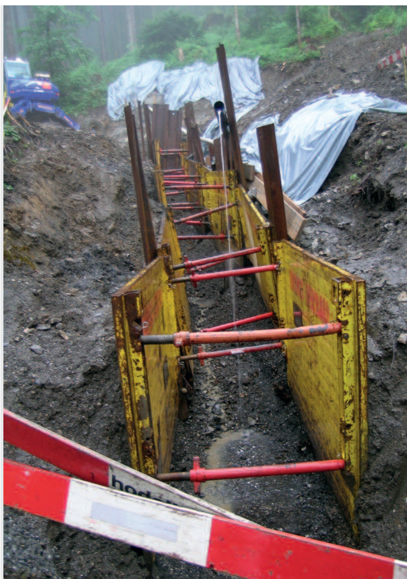
Die über 100-jährige Leitung bei der Quelfassung Ottenfang musste erneuert werden.
