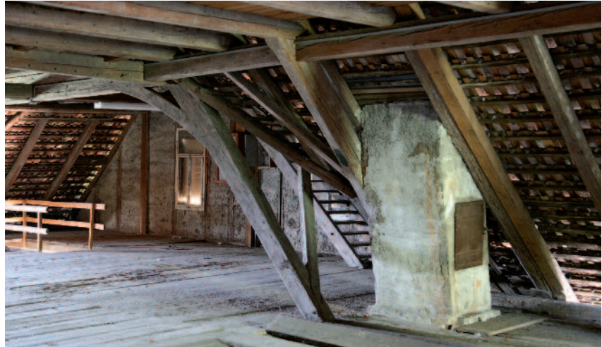
Blick in die Ständerkonstruktion im Obergeschoss.
