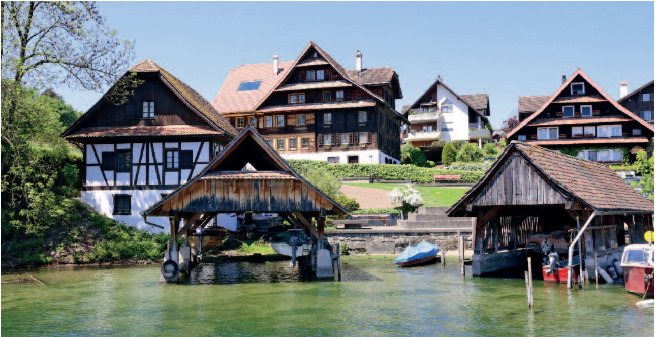
Bei der Gemeindegalerie Benzholz «Raum für zeitgenössische Kunst» (links im Bild) muss das Dach saniert werden.
