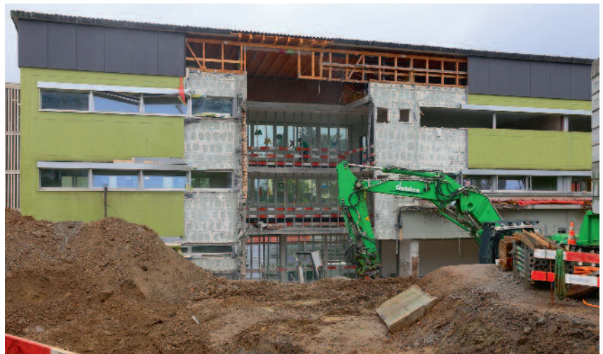
Abbrucharbeiten auf der Rückseite des Schulhauses Hofmatt 1.
