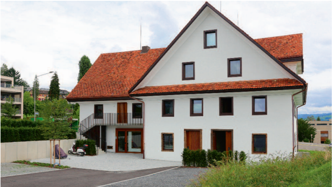
Die denkmalgeschützte Kreuztrotte nach ihrer Renovation.
