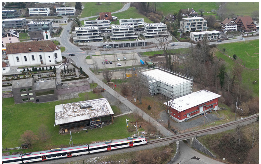
Erstellung der Wohncontainersiedlung im Gebiet Gottlieben.
