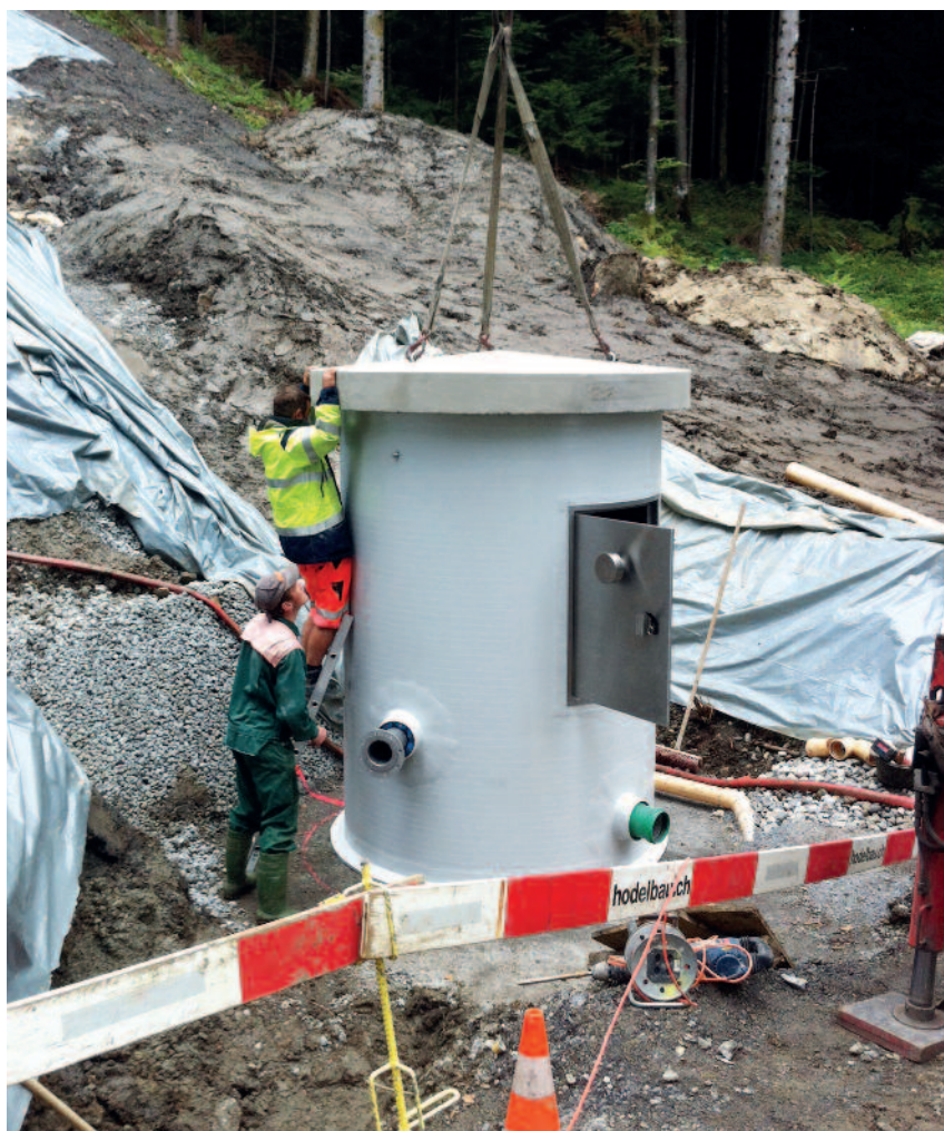
Aus der Gmeindsposcht Nr. 4/2015: Sanierung der Quellen Ottenfang, Fassungen 9 und 12: Die neue Brunnenstube des Typs «Aquaniro» mit inneren Ausbauten aus Chromstahl wird installiert.
