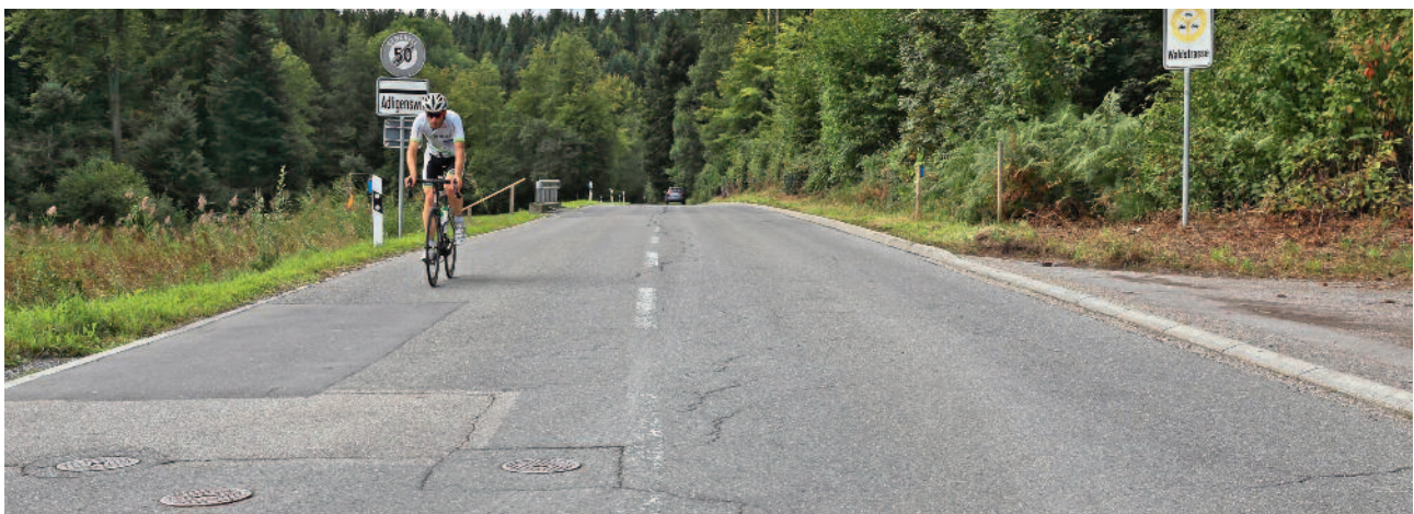
Adligenswilerstrasse: Mit der Erstellung eines Rad- und Gehweges wird die Sicherheit verbessert.
