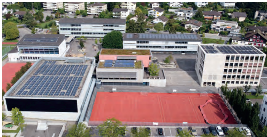
Das Schulzentrum Hofmatt aus der Vogelperspektive. Auf den Dächern der Schulhäuser Hofmatt 1 und 4 sowie an der Fassade der Sporthalle sind die Photovoltaikanlagen gut zu erkennen.
