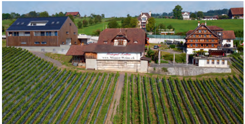
Das Weingut Letten aus der Luft, auf der linken Seite der Neubau mit Eventraum und Vinothek.
