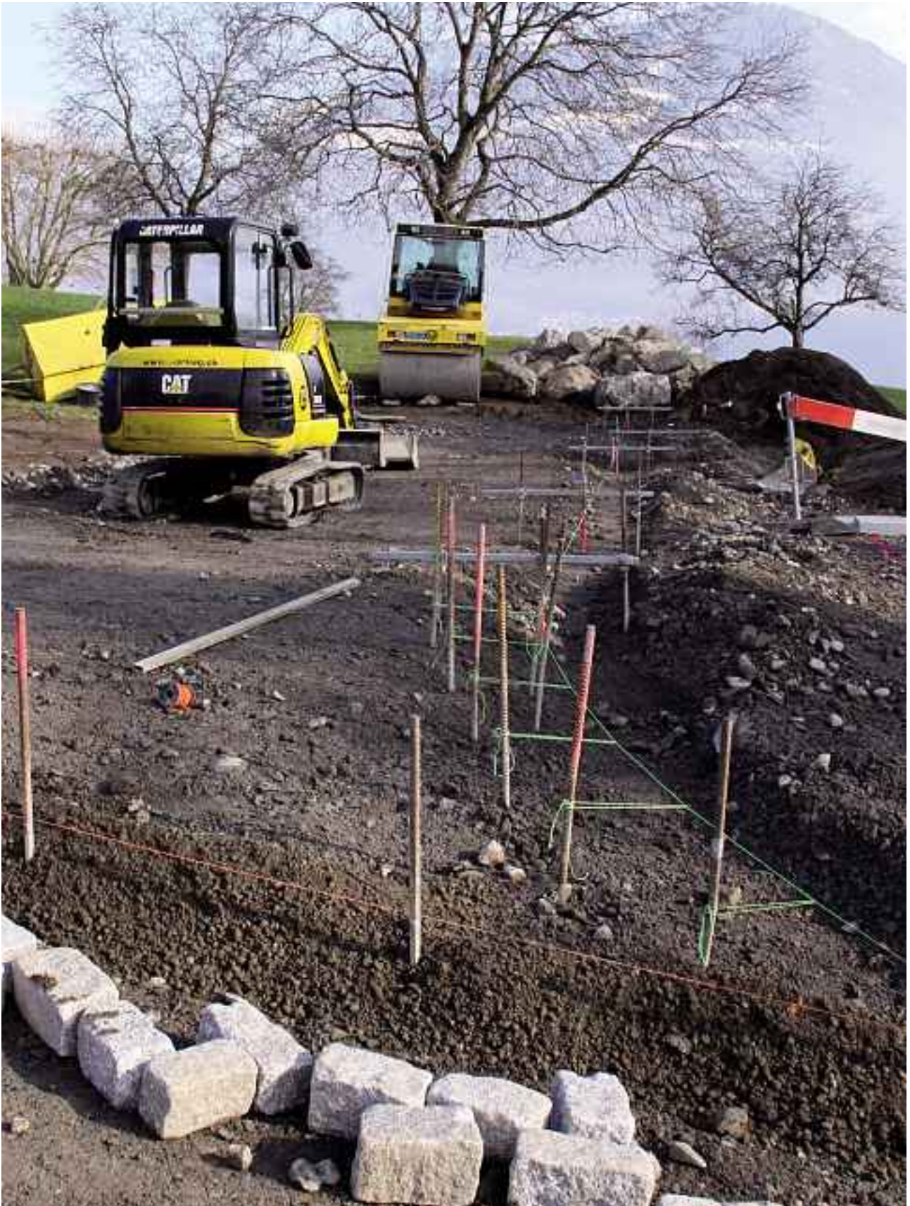
Sanierung und Ausbau Sentibühlstrasse Süd: Die Gemeinde Meggen investierte im Jahr 2009 insgesamt 6,7 Mio. Franken in Tief- und Hochbauprojekte.
