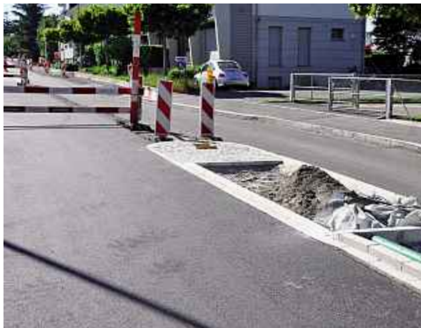
Im Jahr 2009 liefen die Arbeiten für den Ausbau und die Sanierung der Kreuzbuchstrasse, Abschnitt Buchmatt bis Rustica, auf Hochtouren.
