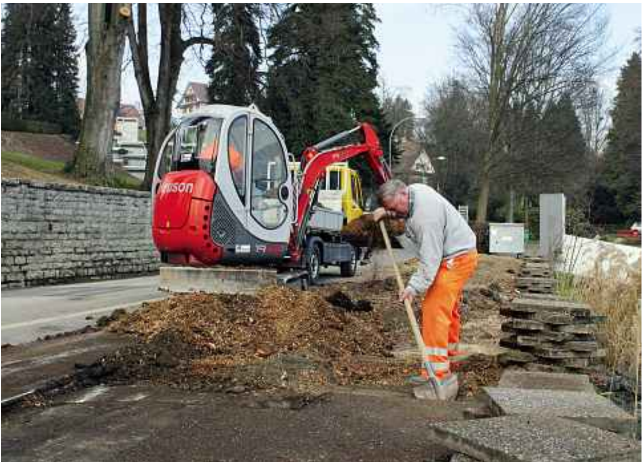
Mitarbeiter des Werkdienstes bei Anpassungsarbeiten an der Seestrasse.
