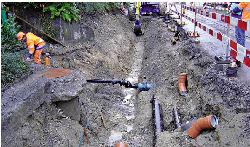
Kanalisationsarbeiten an der Kreuzbuchstrasse
