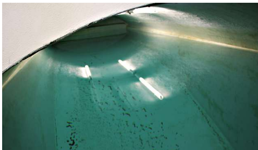
Reservoir der Wasserversorgung Meggen
