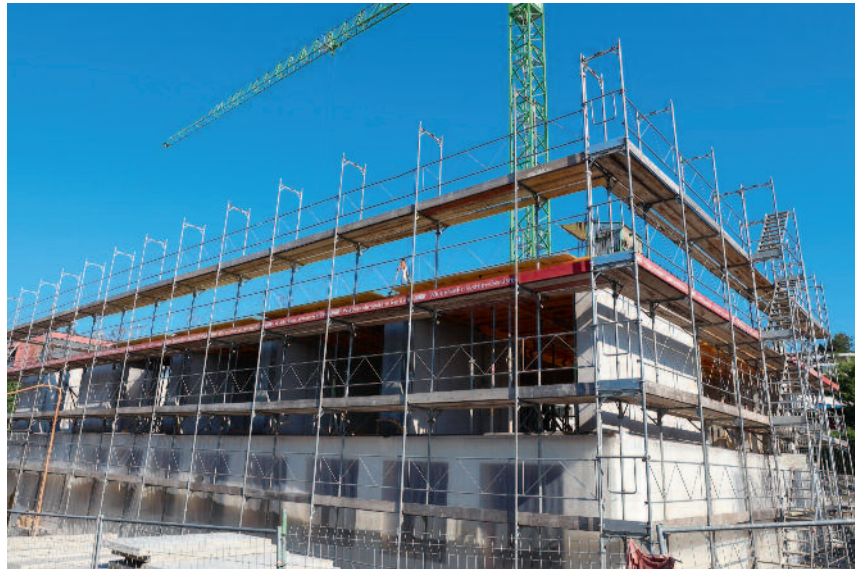
20. Juni 2017: Der Rohbau des Neubaus Hofmatt 4 wächst in die Höhe.
