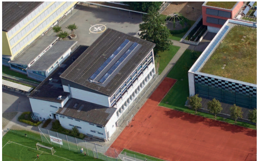
Die Luftaufnahme zeigt die Solaranlage auf dem Dach des Hallenbads.
