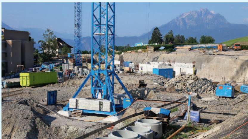
Baustelle in Meggen mit Blick zum Pilatus.
