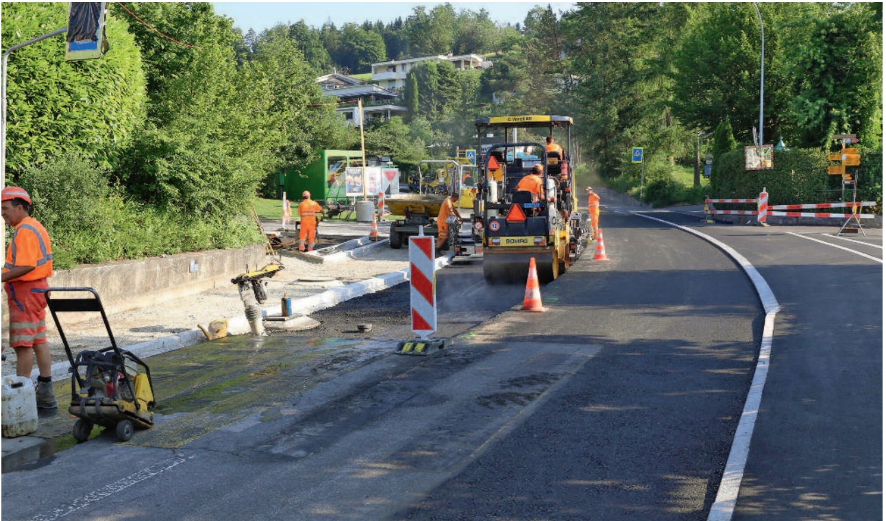
Bauarbeiten am 20. Juni 2017 für die Anpassung des Knotens Tschädigen.
