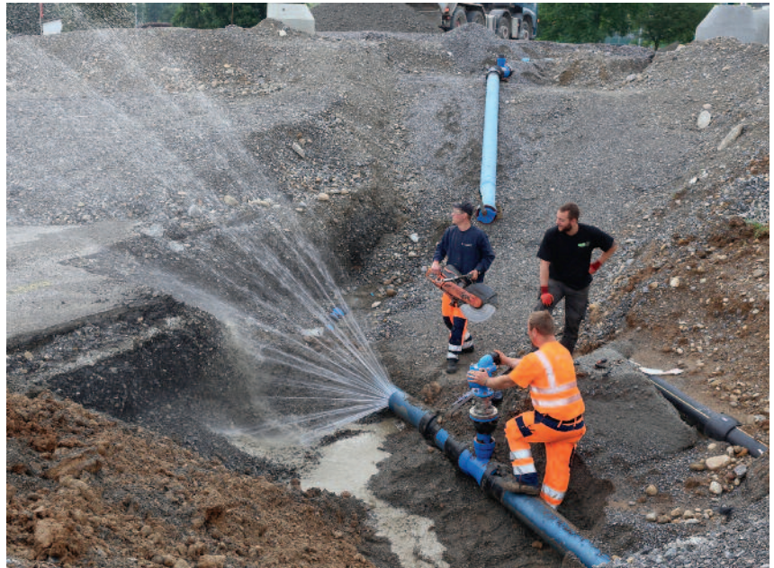
Neue Linienführung für die Transportwasserleitung der Gemeinde Meggen: Vorarbeiten im Bereich der Baustelle der Südumfahrung Küssnacht wurden bereits ausgeführt.
