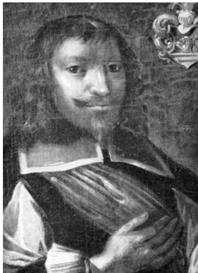
Gardehauptmann Jost von Meggen.
